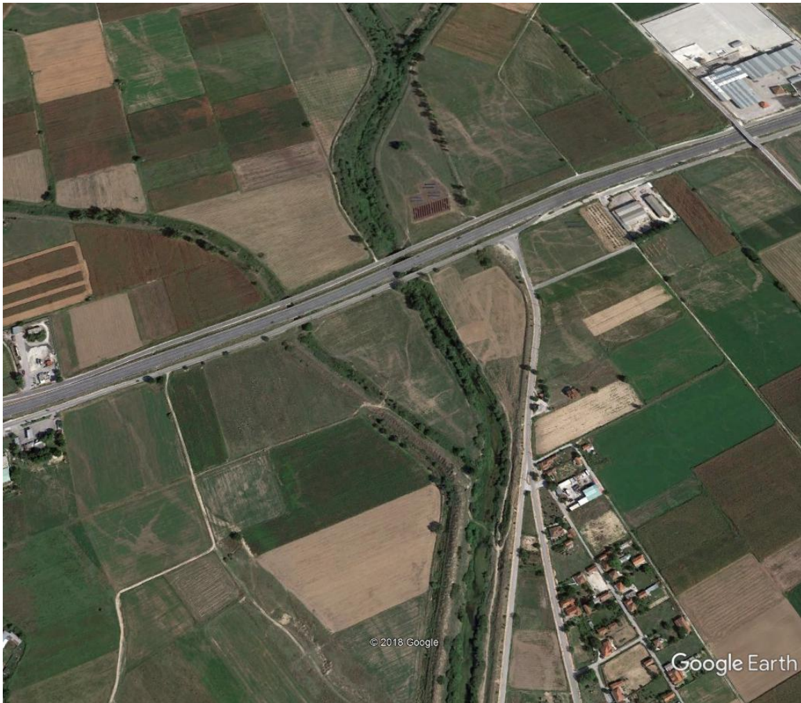
Εικόνα 2.33: Δορυφορική απεικόνιση περιοχής υδρομετρικού σταθμού Γέφυρας Κλοκωτού
