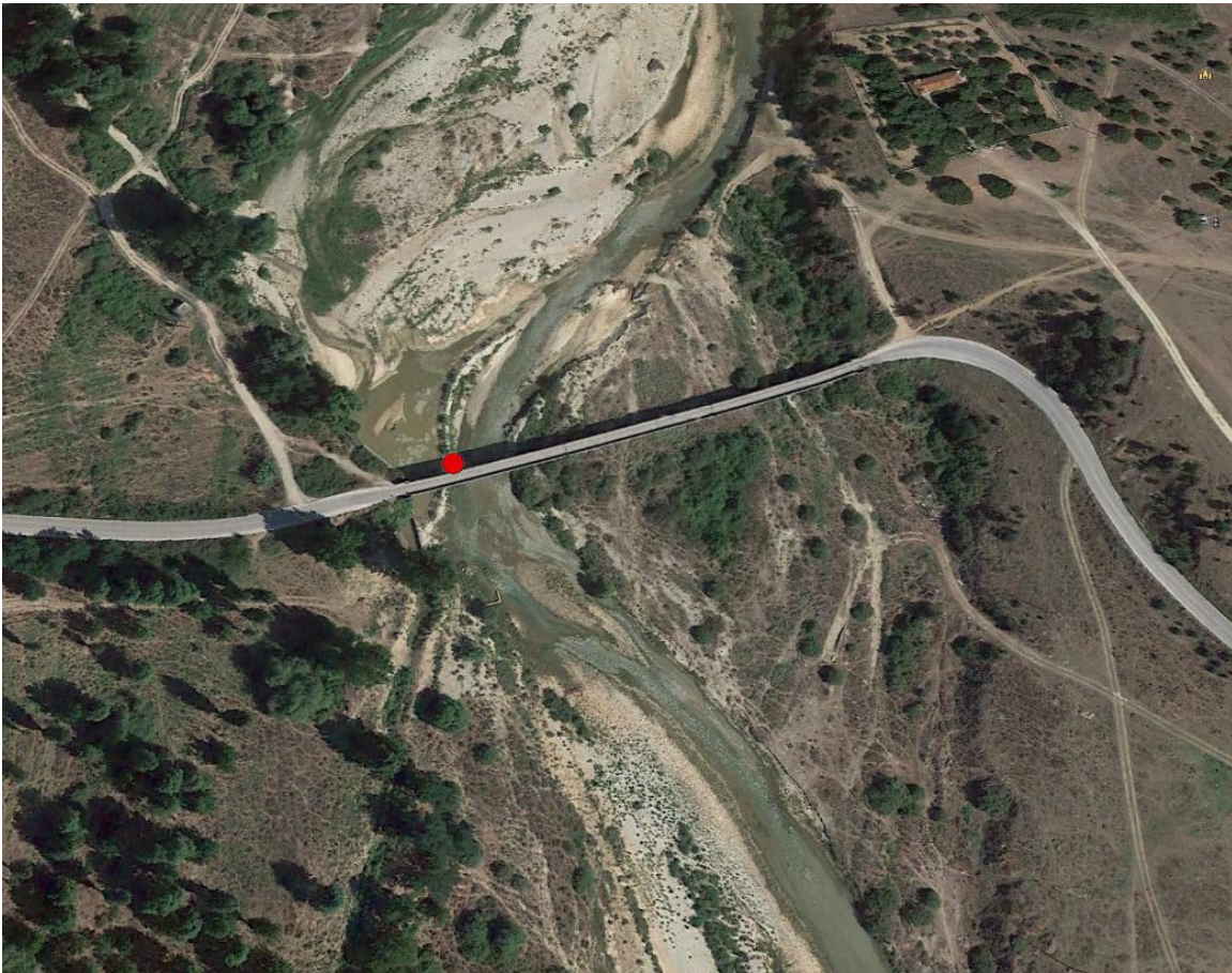
Εικόνα 2.35: Δορυφορική απεικόνιση περιοχής υδρομετρικού σταθμού Γέφυρας Μυλογούστας (Μεσοχώρι)
