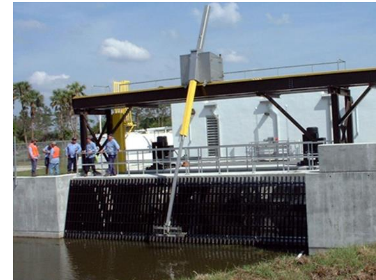
Εικόνα 27: Παράδειγμα καθαρισμού εσχάρας με μηχάνημα (Πηγή: mavideniz.com)
