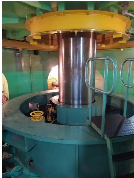
Εικόνα 33: Όψη στροβίλου τύπου Francis
