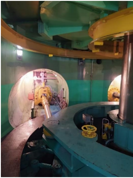
Εικόνα 33: Όψη στροβίλου τύπου Francis
