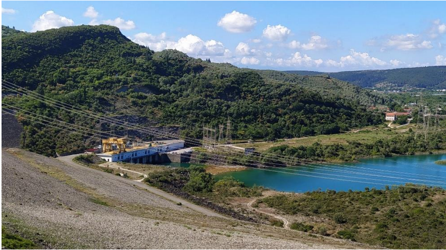
Εικόνα 30: Ο σταθμός παραγωγής ενέργειας
