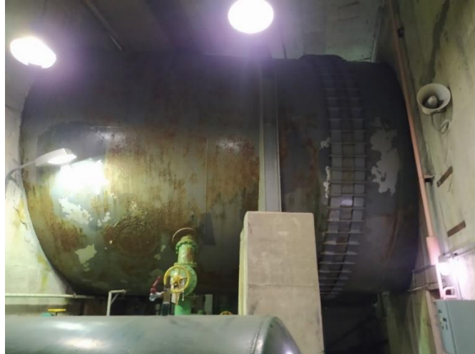
Εικόνα 40: Ενδεικτική σύνδεση της σήραγγας υδροληψίας με τον στρόβιλο
