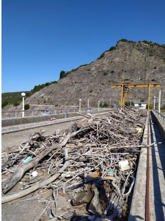
Εικόνα 29: Η γερανογέφυρα των απορριμμάτων
