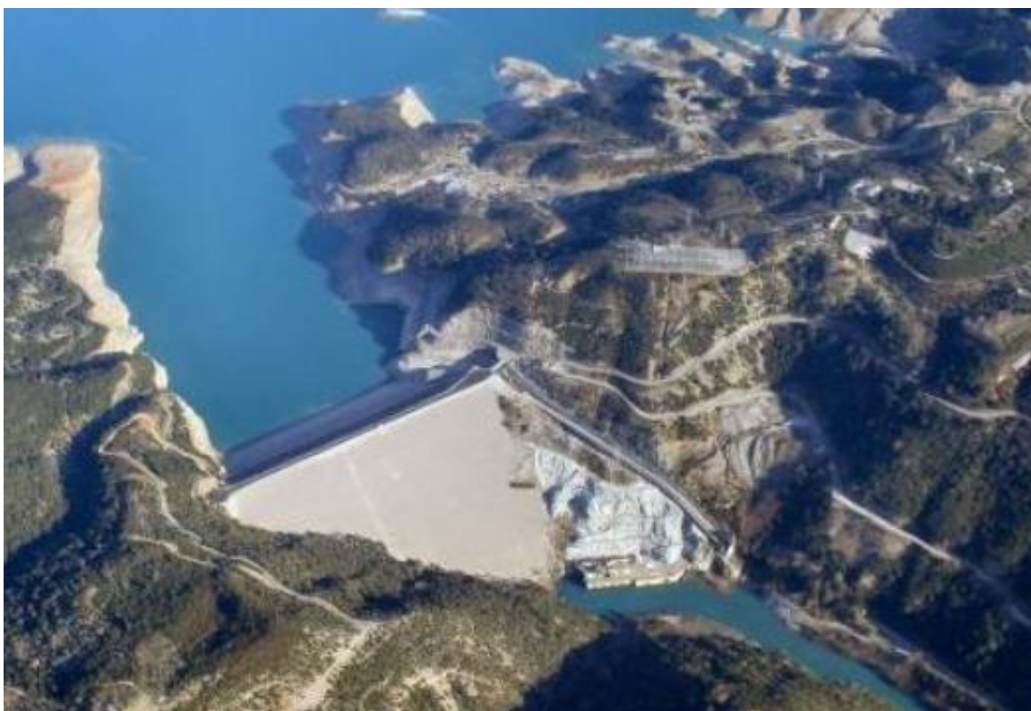
Εικόνα 7: Πλευρικός υπερχειλιστής γεωφράγματος στο αριστερό αντέρεισμα
