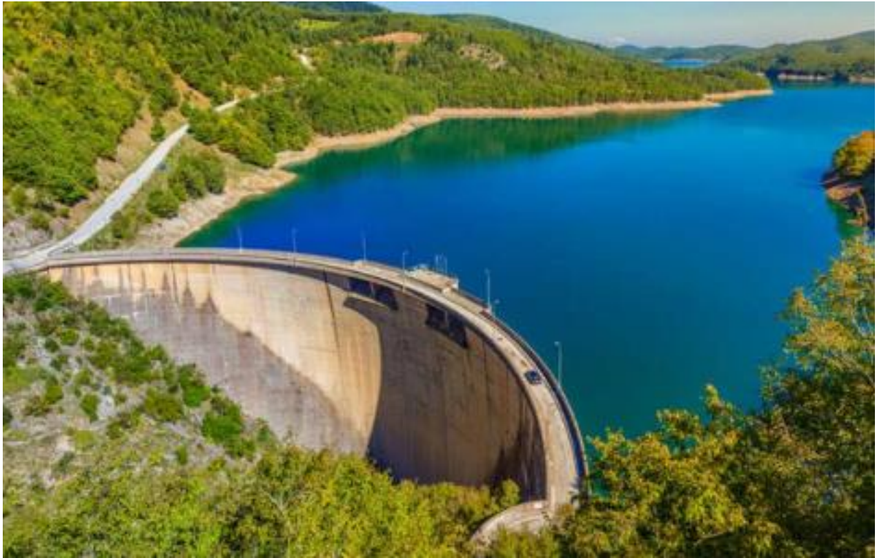
Εικόνα 3: Τοξωτό φράγμα Πλαστήρα στον ποταμό Αχελώο
