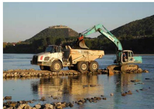
Εικόνα 5.7 Κατασκευή προβόλων Πηγή: Manual on Danube Navigation, 2019
