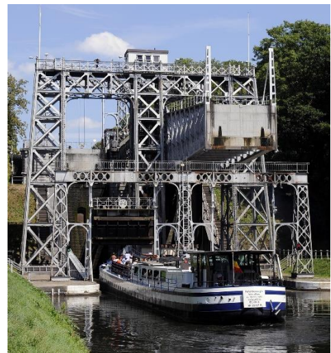
Εικόνα 3.2 Υδραυλική κλεισιάδα στη «Διώρυγα του Κέντρου» | Πηγή: voiesdeau.hainaut.be
