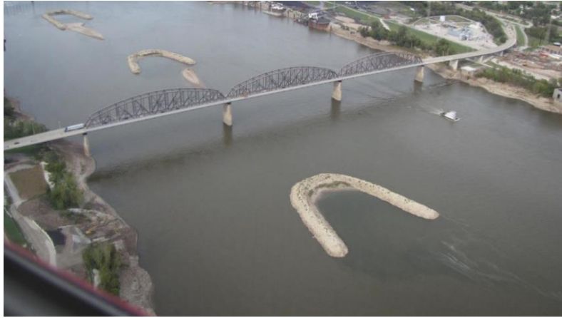
Εικόνα 5.3 Κατασκευή παράλληλου (στη ροή) προβόλου (chevron) Πηγή: Mississippi - St. Louis Harbor. Mosenien Project, U.S. Army Corps of Engineers
