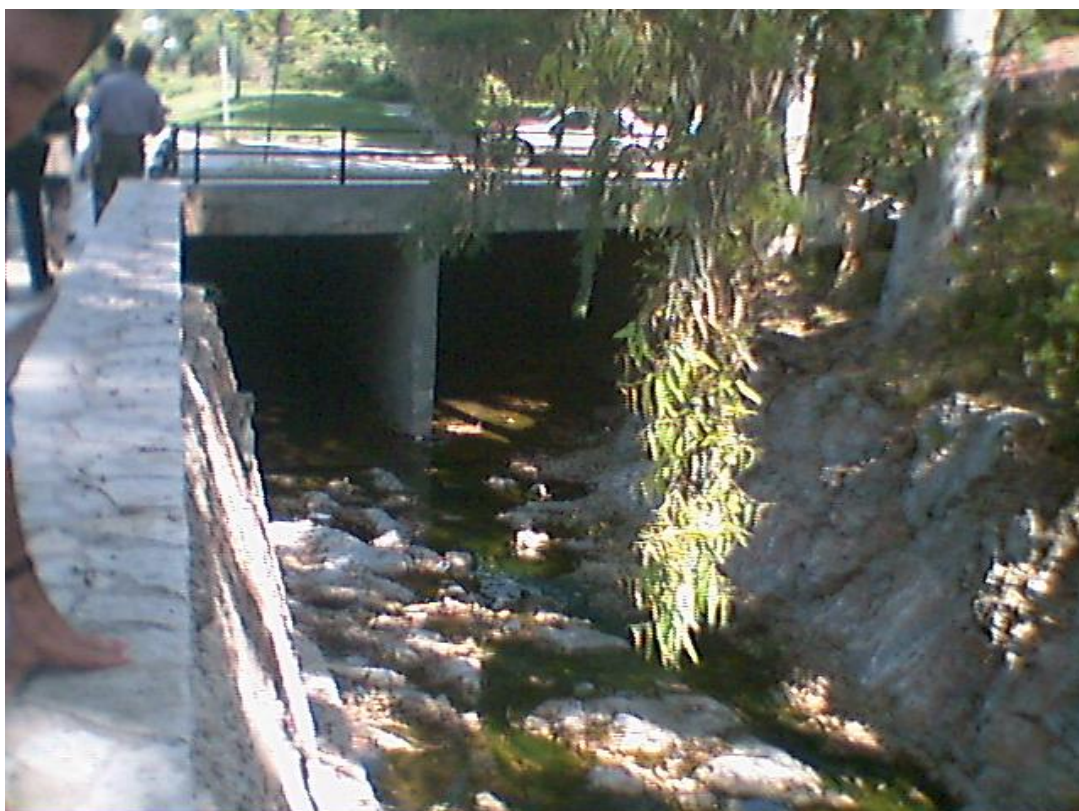
Σχ. 3 Φωτογραφία του κατάντη πέρατος της ανοιχτής κοίτης του ρέματος Φιλοθέης.
