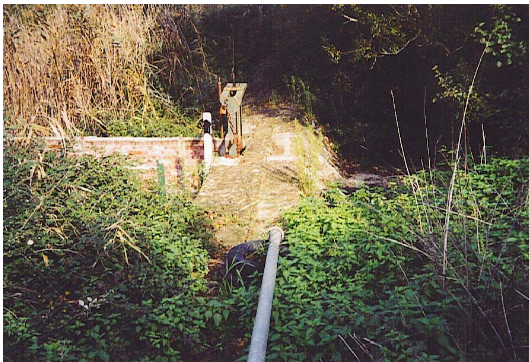
Φωτ. 2 Το έργο υπερχείλισης, στο ανατολικό όριο της λίμνης, μέσω του οποίου ελέγχεται η ανώτατη στάθμη της λίμνης. Διακρίνεται και το έργο ελέγχου της ροής στον υδραύλακα (ενσωματωμένο στο έργο υπερχείλισης).
