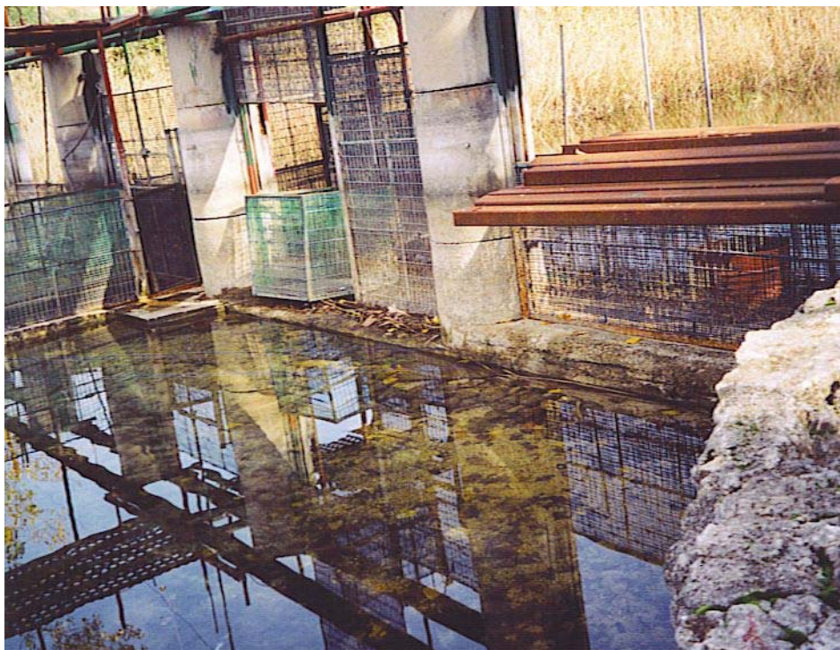
Φωτ. 4 Οι υπάρχουσες εγκαταστάσεις ιχθυοτροφικής εκμετάλλευσης στο ανατολικό όριο της λίμνης Ζαραβίνας (στην περιοχή του έργου υπερχείλισης και του υδραύλακα).
