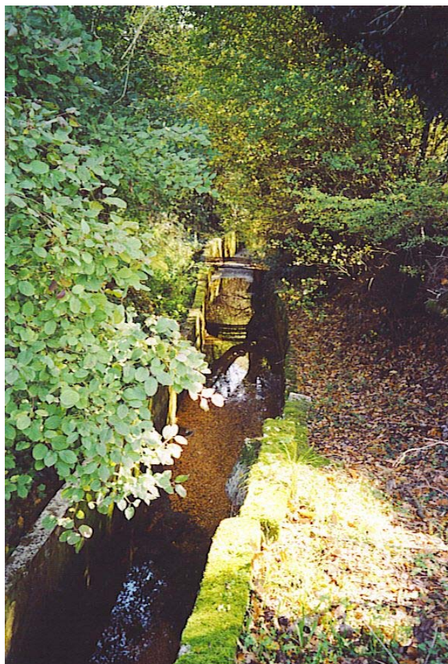
Φωτ. 3 Ο υδραύλακας, στο ανατολικό όριο της λίμνης, μέσω του οποίου μπορεί να διοχετευτεί νερό από τη λίμνη προς τις κατάντη περιοχές για άρδευση.
