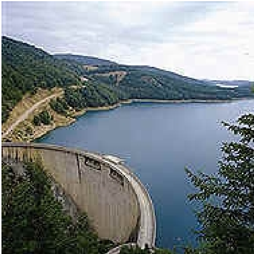
Σχ. 2: Το φράγμα
