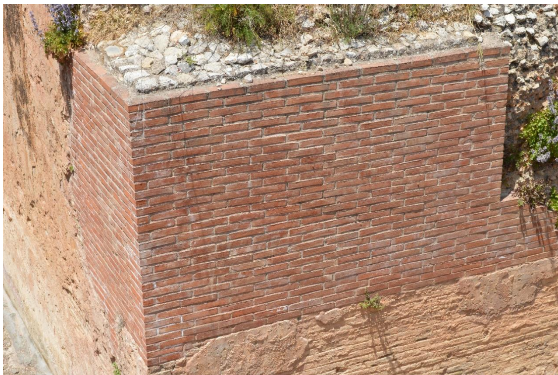
Εικόνα 6 : Συμπλήρωση τοιχοποιίας της δεξαμενής σχήματος Γ
