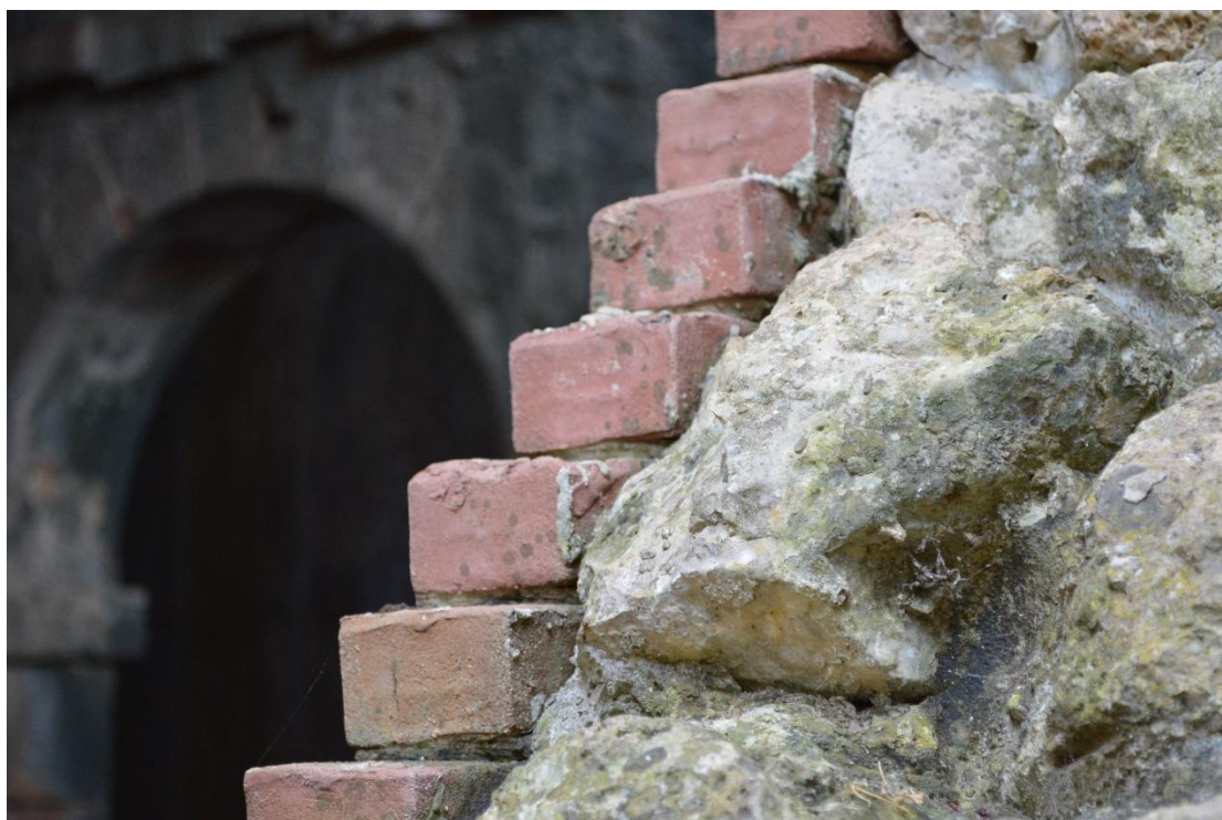
Εικόνα 17 : Λεπτομέρεια επιπρόσθετης τοιχοποιίας τρίκλιτης δεξαμενής
