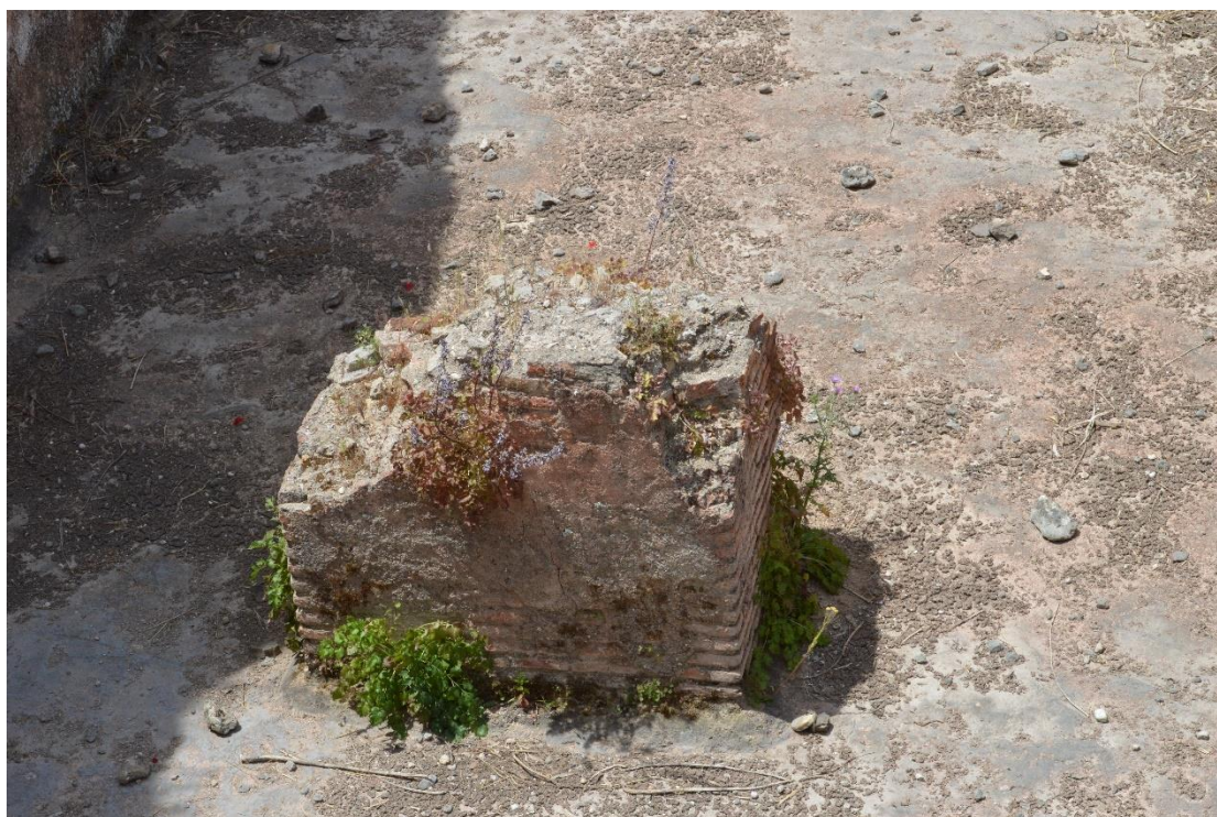
Εικόνα 3 : Ενδιάμεσος πεσσός που βοηθούσε στην στήριξη της οροφής της δεξαμενής σχήματος Γ
