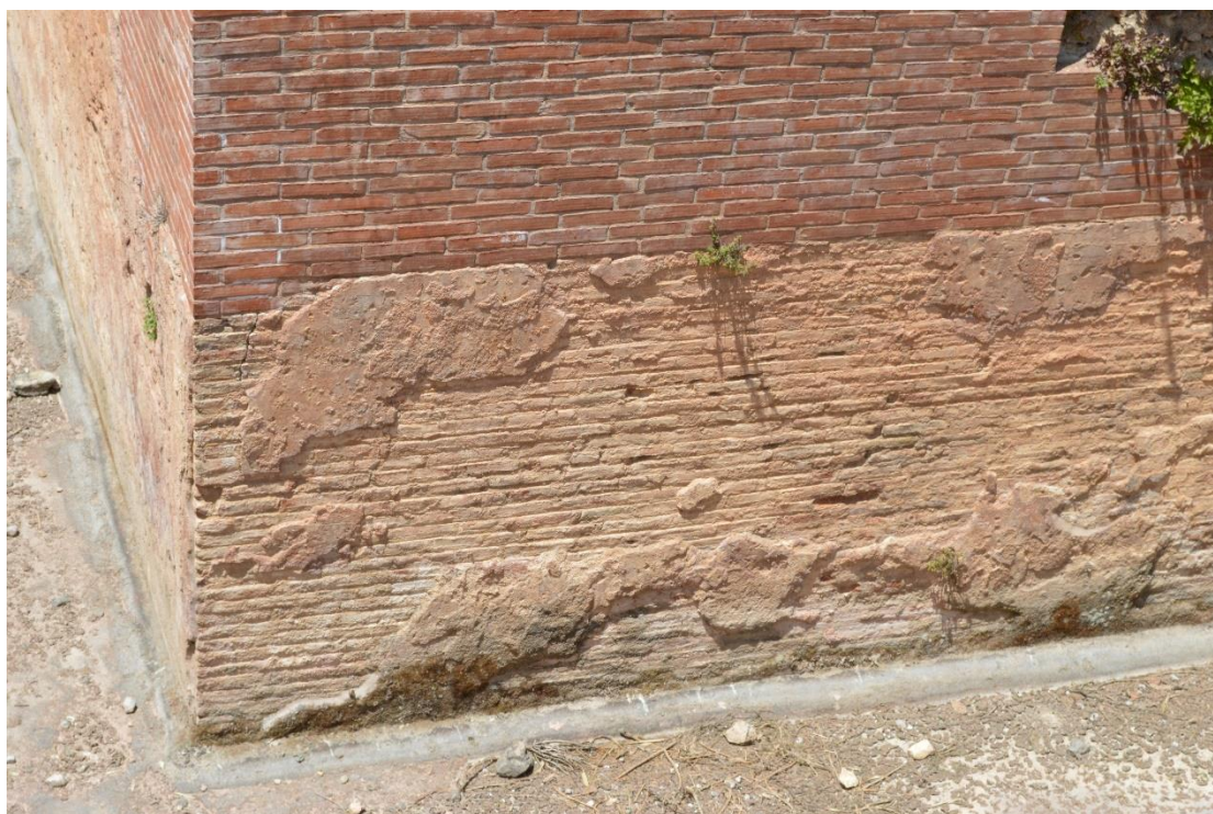
Εικόνα 5 : Τμήμα της αυθεντικής τοιχοποιίας της δεξαμενής σχήματος Γ
