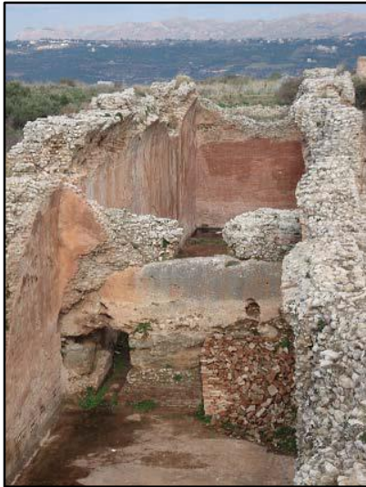
Σχήμα 1.13 : Φθορές στην τοιχοποιία και στον θόλο
