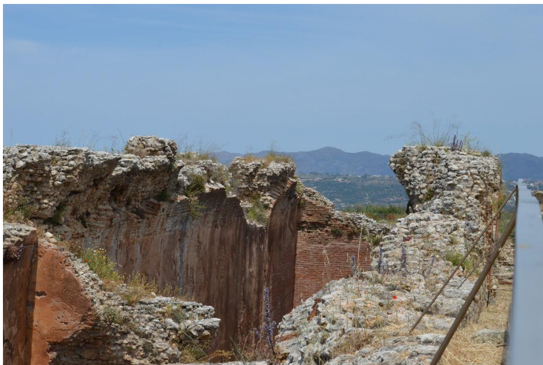
Εικόνα 4 : Απομείναντα κομμάτια της οροφής της δεξαμενής σχήματος Γ
