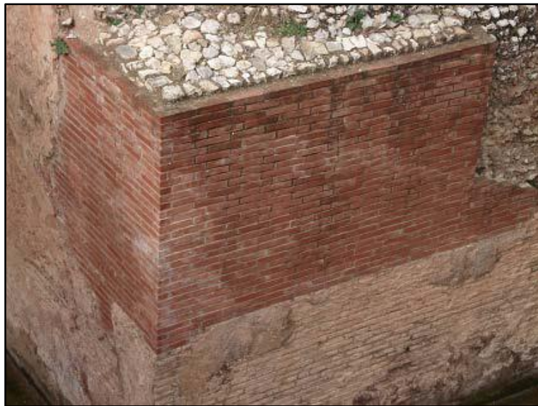
Σχήμα 1.15 : Συμπλήρωση τοιχοποιίας
