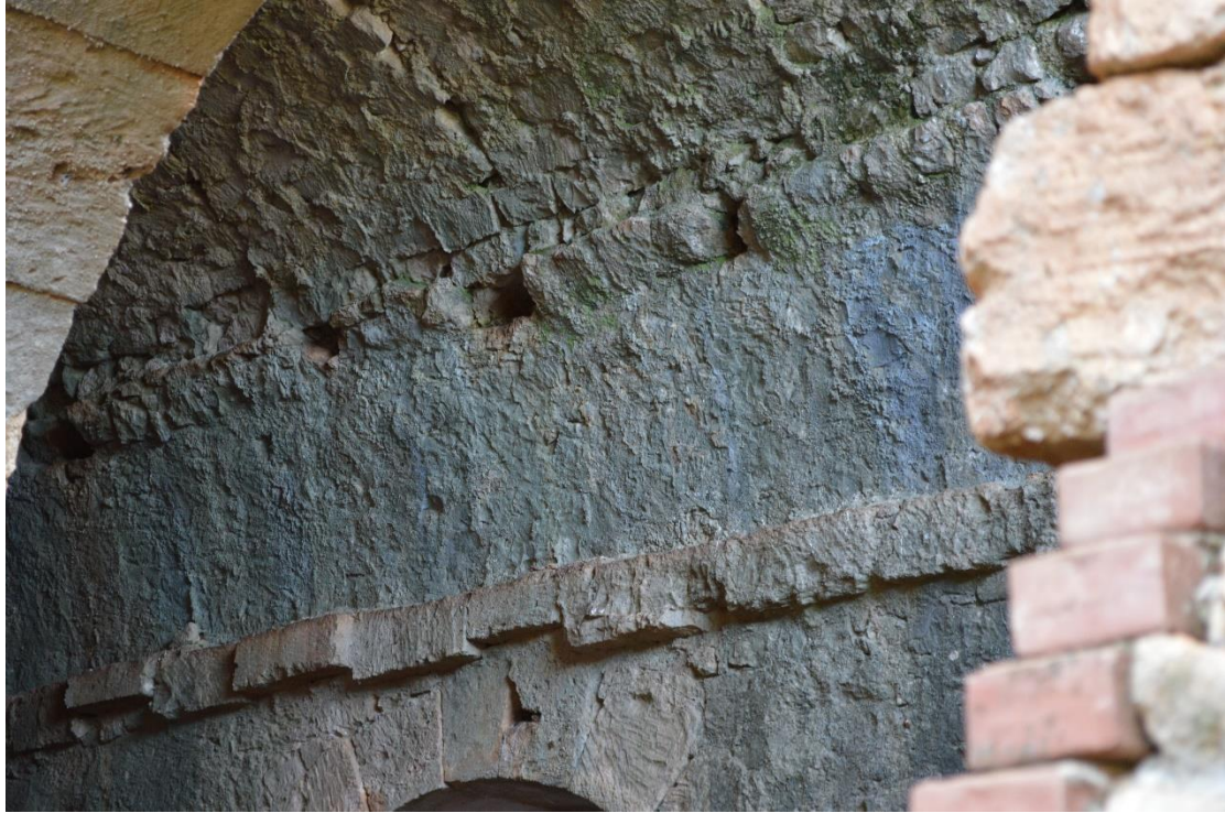
Εικόνα 13 : Τρύπες στην οροφή της τρίκλιτης δεξαμενής για την εισροή του νερού
