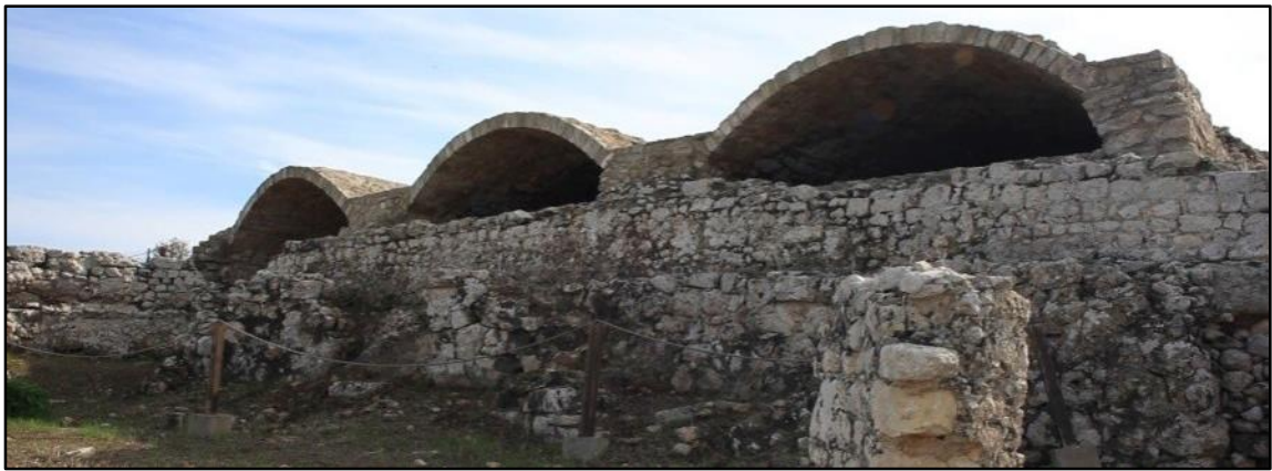
Σχήμα 1.7 : Εξωτερική άποψη τρίκλιτης δεξαμενής
