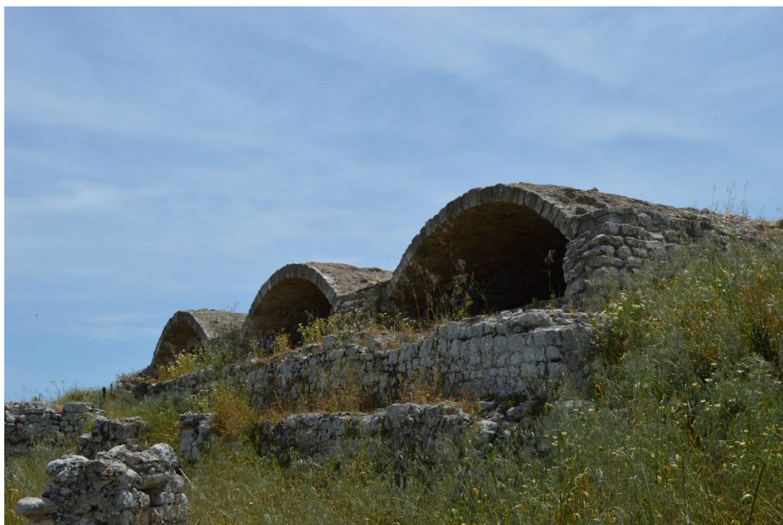
Εικόνα 7 : Εξωτερική άποψη τρίκλιτης δεξαμενής
