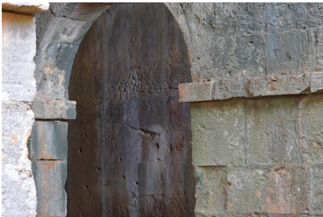
Εικόνα 18 : Λεπτομέρεια πεσσού τρίκλιτης δεξαμενής
