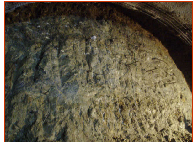
«Αθηναϊκός Σχιστόλιθος» στο μέτωπο εκσκαφής
