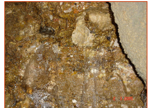
Συμπαγές κροκαλοπαγές στο μέτωπο εκσκαφής
