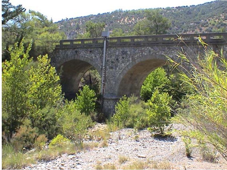
Εικόνα 1.10: Γέφυρα Λαέρμων, όπου είναι εγκατεστημένος ο σταθμηγράφος.
