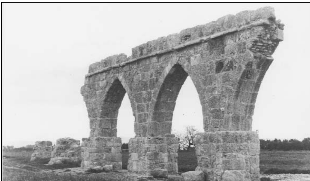
Εικόνα 45: Πέτρινο υδραγωγείο μεταφοράς νερού από την Κυθρέα στη Σαλαμίνα, στον Άγιο Σέργιο
