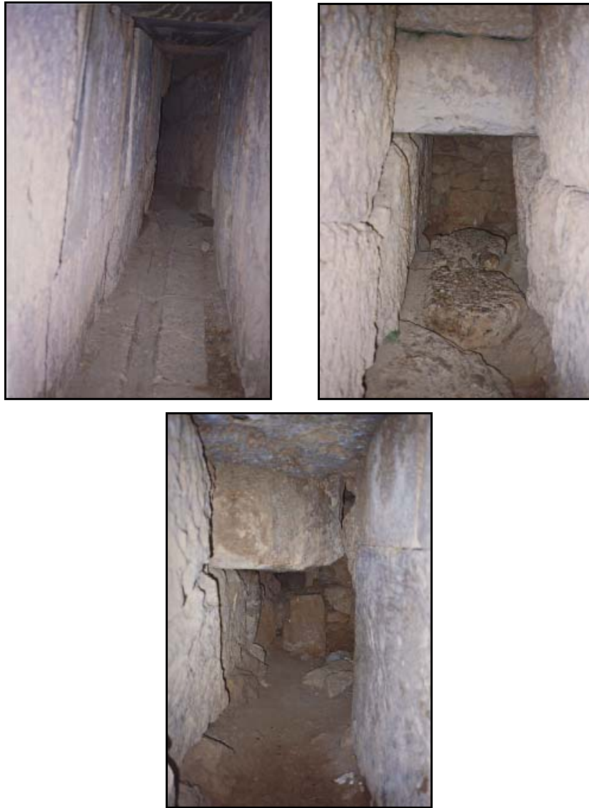
Εικόνα 20: Η δαιδαλώδης διακλάδωση του υπογείου αγωγού της Κασσοτίδας, που διαπερνούσε τα θεμέλια του ναού του Απόλλωνα
