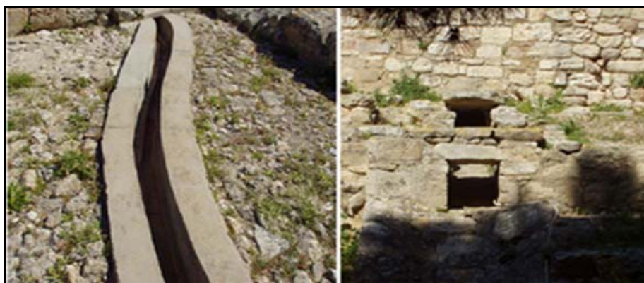
Εικόνα 5: Τμήματα του συστήματος αποχέτευσης στο ανάκτορο της Κνωσού, εντός του ανακτόρου (αριστερά) και στην έξοδο του κεντρικού αποχετευτικού αγωγού (δεξιά)
