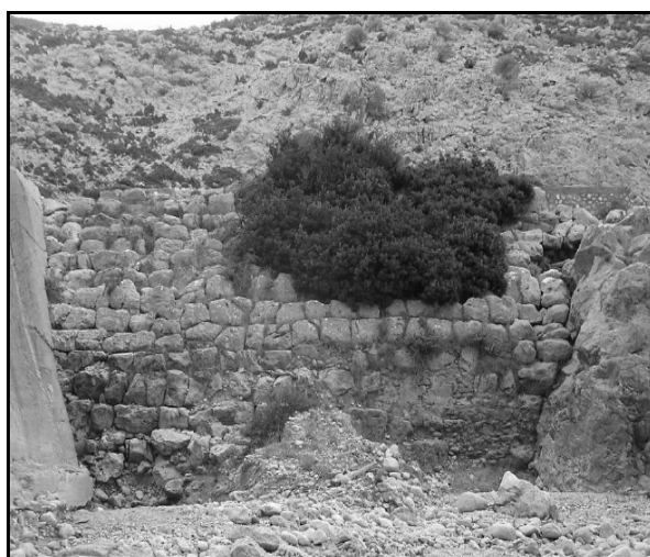
Εικόνα 58: Κατάντη παρειά του φράγματος (08/2004)
