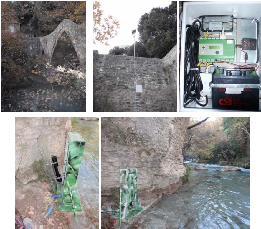
Εικ. 19: Ροομετρικός σταθμός Λούσιου (Γέφυρα Ατσίχολου).
