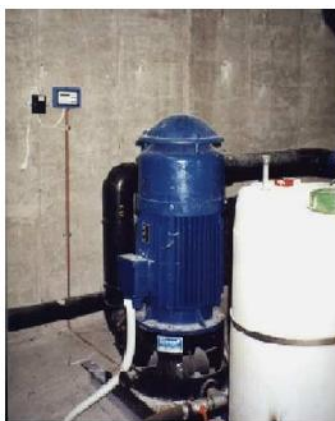
Εικόνα 3-17. Γεωθερμική αντλία στην εγκατάσταση αφαλάτωσης στην Κίμωλο (Tzen & Morris, 2003)
