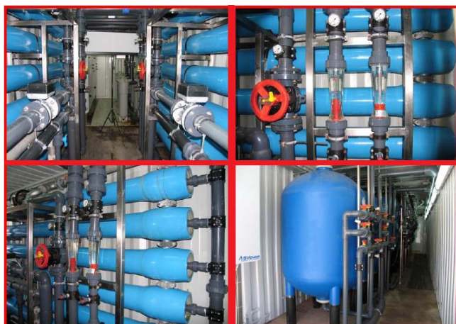
Εικόνα 3-21. Άποψη του εσωτερικού της μονάδας αφαλάτωσης (ΙΤΑ, 2008)
