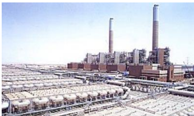
Εικόνα 3-12. Η μονάδα αφαλάτωσης MSF “Shuaiba 3”
