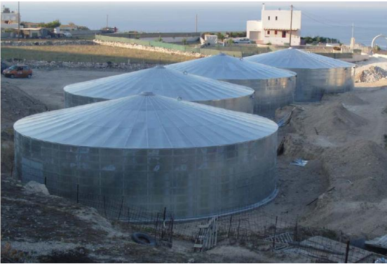
Εικόνα 3-23. Οι 4 δεξαμενές λειτουργίας της μονάδας αφαλάτωσης, χωρητικότητας 3.000 m 3 (ΙΤΑ, 2008)
