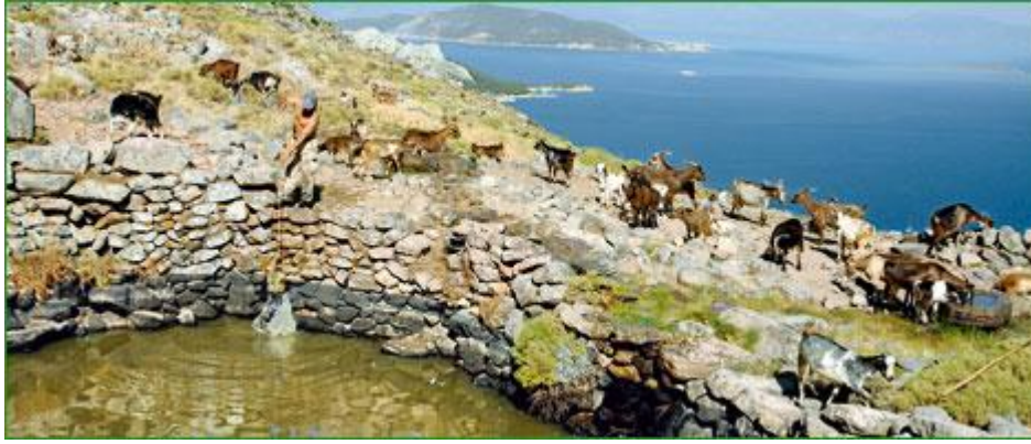
Εικόνα 2-19. Πετρόχτιστη αυτοσχέδια στέρνα για τη συλλογή όμβριων υδάτων και πότισμα αιγοπροβάτων σε νησί του Αιγαίου (Ζαβιτσάνου, 2008)
