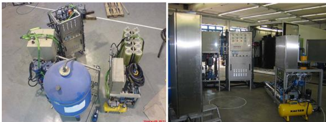
Εικόνα 3-26. Άποψη του εσωτερικού της μονάδας αφαλάτωσης (Technava SA, 2008)
