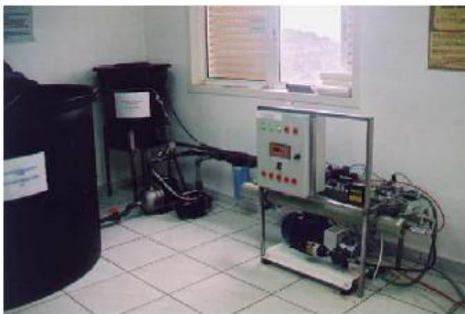
Εικόνα 3-19. Εγκατάσταση Αντίστροφης Όσμωσης, δυναμικότητας 130 lt/ώρα, στην Κερατέα (Tzen & Morris, 2003)
