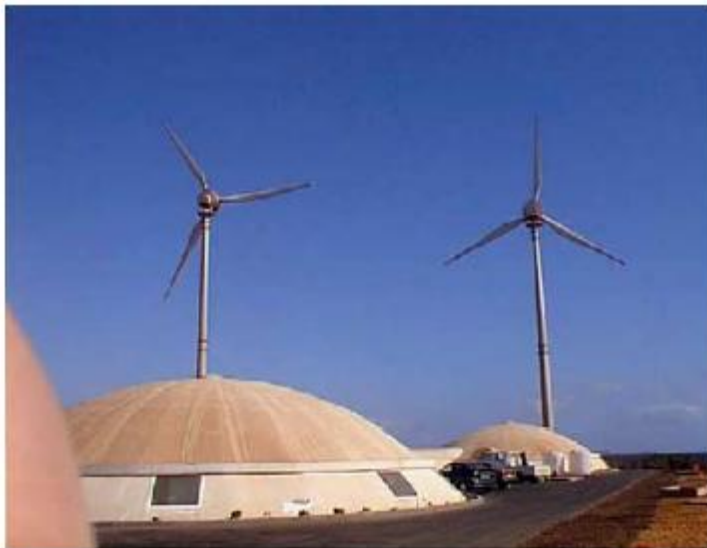
Εικόνα 3-14. Αιολικό πάρκο και εγκατάσταση αφαλάτωσης στη νήσο Gran Canaria, της Ισπανίας (Tzen & Morris, 2003)
