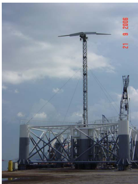
Εικόνα 3-25. Πλωτή μονάδα αφαλάτωσης στην Ηρακλεία (Technava SA, 2008)
