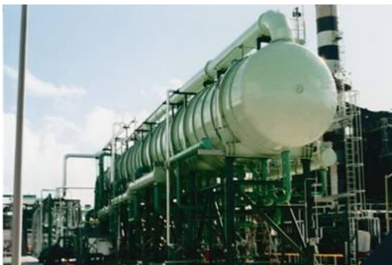
Εικόνα 3-8. Εγκατάσταση Απόσταξης Πολλαπλής Επίδρασης (IDS WATER, 2006)
