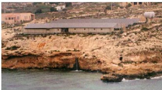
Εικόνα 3-15. Εγκατάσταση PV-RO, στην Ιταλία (Lampedusa) (Tzen & Morris, 2003)
