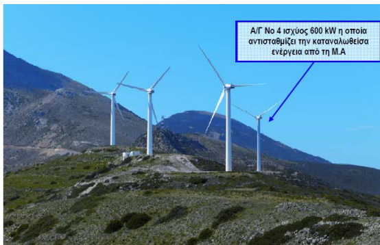
Εικόνα 3-24. Η ανεμογεννήτρια μέσω της οποίας τροφοδοτείται με ρεύμα η μονάδα αφαλάτωσης, στη θέση Κουτσούνοραχη Μήλου (ΙΤΑ, 2008)
