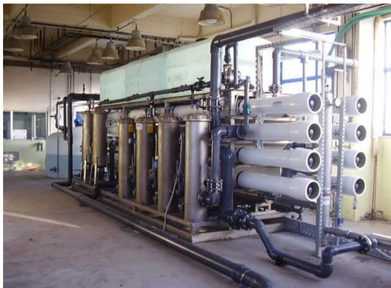
Εικόνα 3-11. Εγκατάσταση αφαλάτωσης με Αντίστροφη Όσμωση (TEMAK, 2009)
