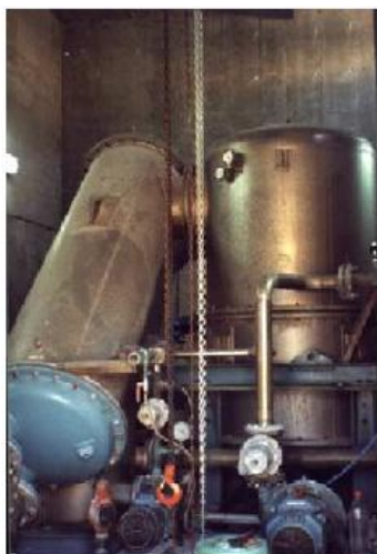
Εικόνα 3-18. Τμήμα της εγκατάστασης MED δυναμικότητας 30 m 3 /ημέρα, στην Κίμωλο (Tzen & Morris, 2003)
