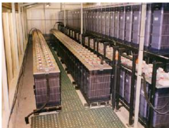
Εικόνα 3-16. Το σύστημα μπαταριών στην εγκατάσταση στη νήσο Lampedusa, της Ιταλίας (Tzen & Morris, 2003)
