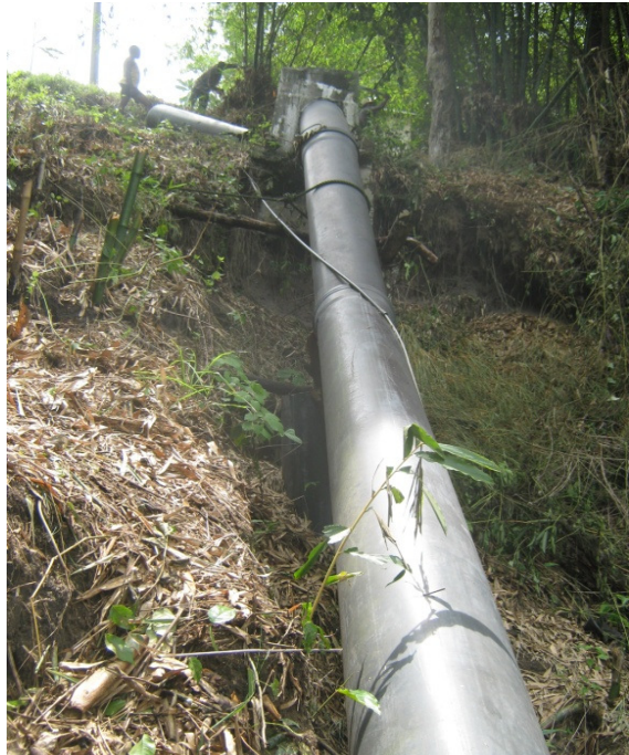
Σχήμα 5.42 Αγωγός πτώσης χωρίς εδαφική επικάλυψη (Πηγή: Politecnico di Bari, 2009)
