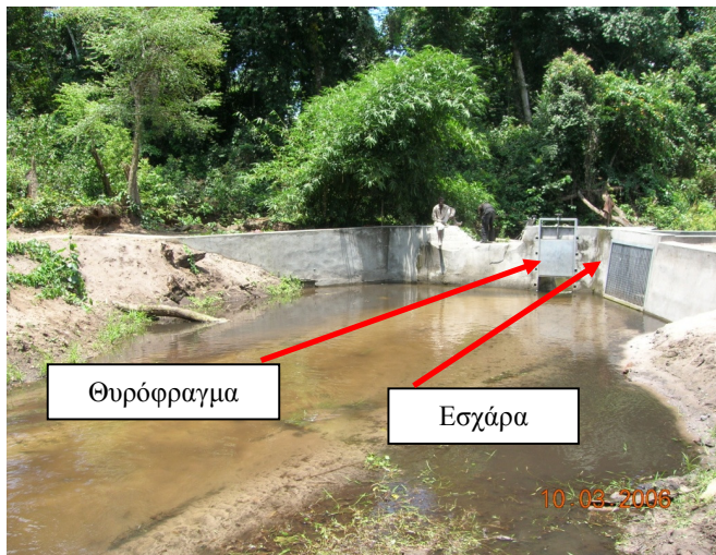
Σχήμα 5.15 Θυρόφραγμα και εσχάρα του υπερχειλιστή (Πηγή: Politecnico di Bari, 2009)
