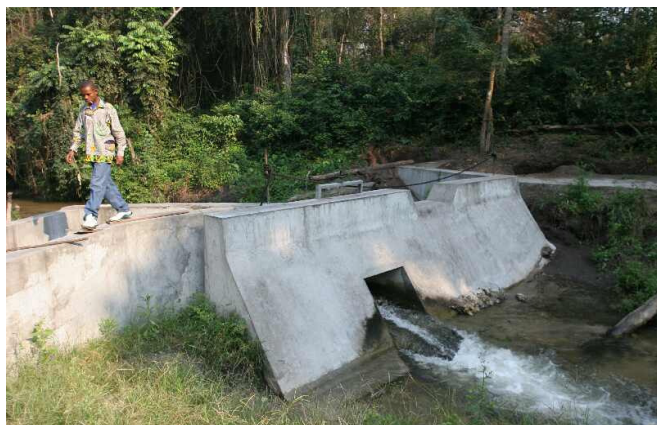
Σχήμα 5.19 – Ανοιχτό θυροφράγμα
