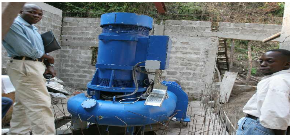
Σχήμα 5.36 Υδροστρόβιλος Francis ZECO n.OF938B (Πηγή: Politecnico di Bari, 2009)
