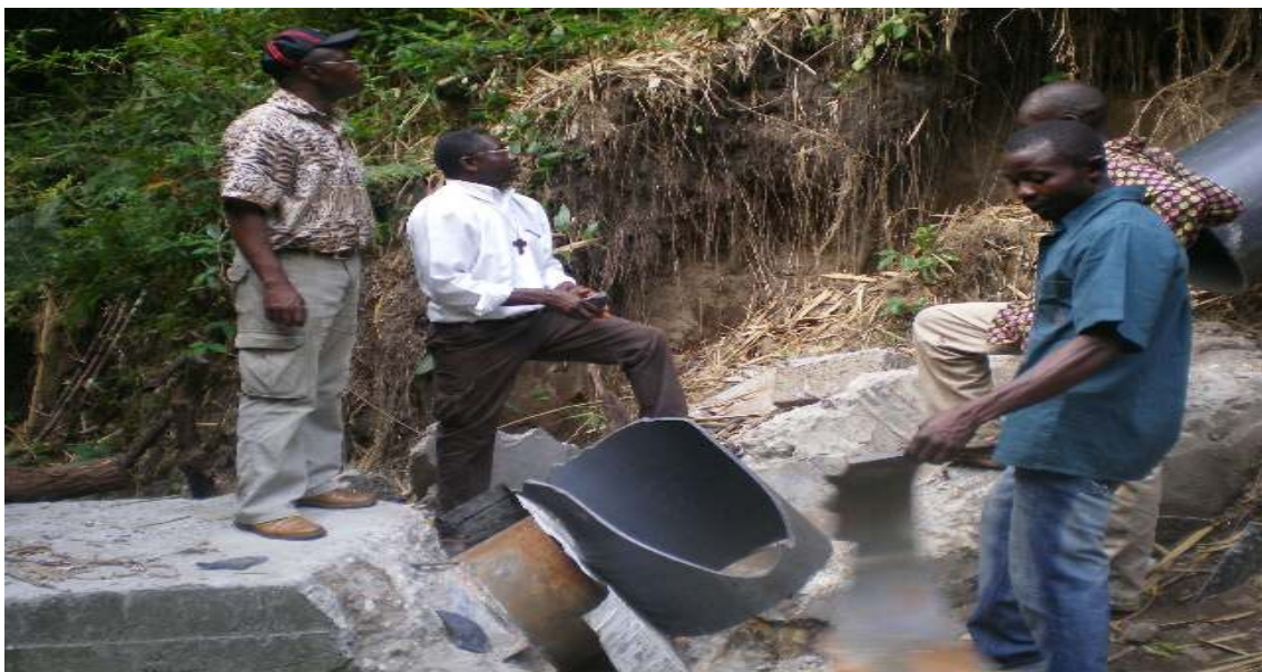
Σχήμα 5.43 Αρχικός αγωγός που διερρήχθη (Πηγή: http://ocdpafrika.wordpress.com/ )
