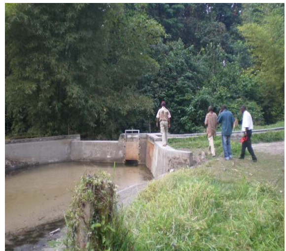
Σχήμα 5.16 Ο υπερχειλιστής του Nzasi με ανοιχτό θυρόφραγμα (Πηγή: http://ocdpafrika.wordpress.com )
