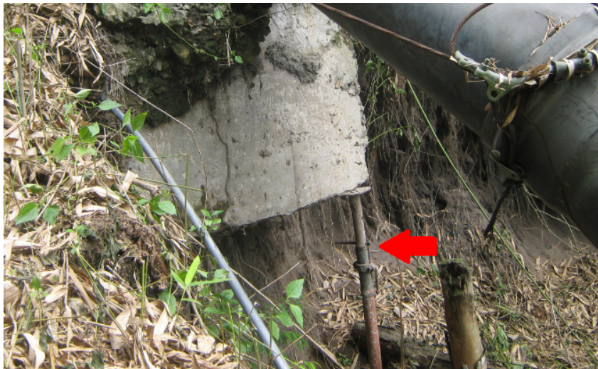
Σχήμα 5.46 Αντηρίδα κάτω από το μπλοκ αγκύρωσης: θέση 1 (Πηγή: Politecnico di Bari, 2009)
