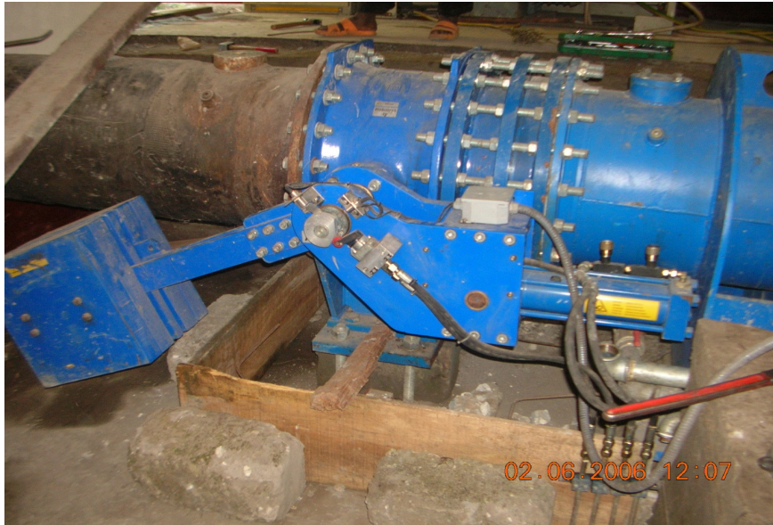
Σχήμα 5.37 Πεταλούδα βαλβίδα ασφαλείας του στροβίλου (Πηγή: Politecnico di Bari, 2009)
