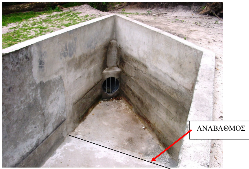
Σχήμα 5.26 Λεπτομέρεια είσοδου του αγωγού τροφοδοσίας (Πηγή: Politecnico di Bari, 2009)
