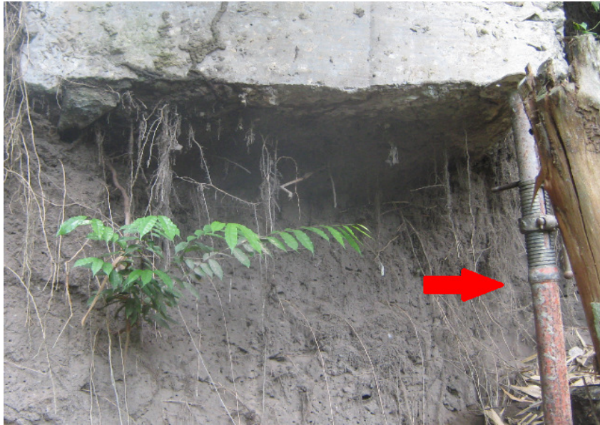
Σχήμα 5.47 Αντηρίδα κάτω από το μπλοκ αγκύρωσης: θέση 1 (Πηγή: Politecnico di Bari, 2009)
