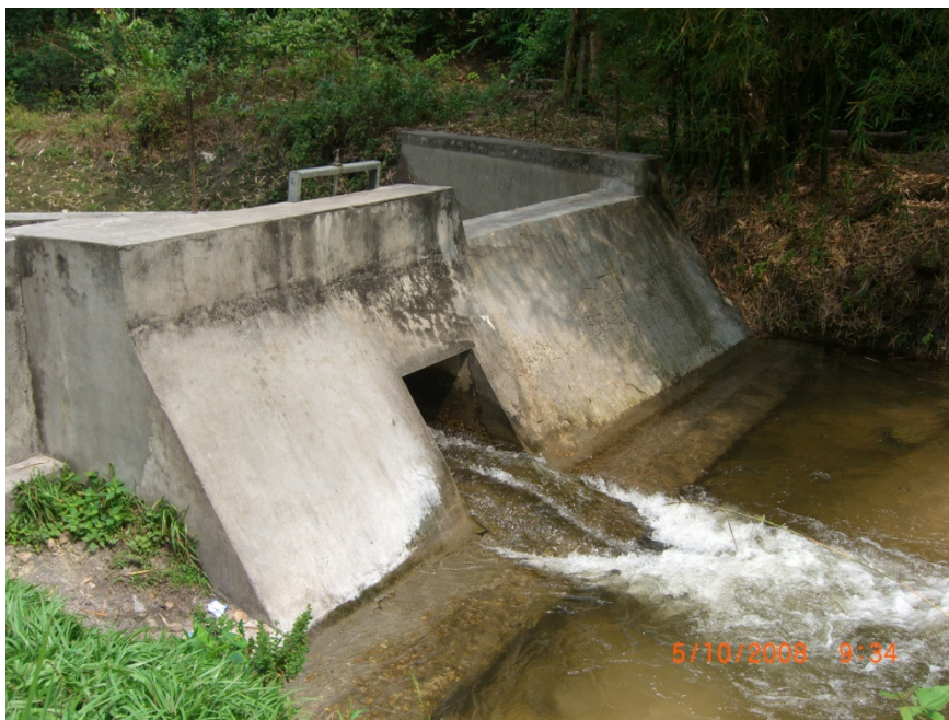
Σχήμα 5.14 Ο υπερχειλιστής του Nzasi με ανοιχτό θυρόφραγμα (Πηγή: Politecnico di Bari, 2009)
