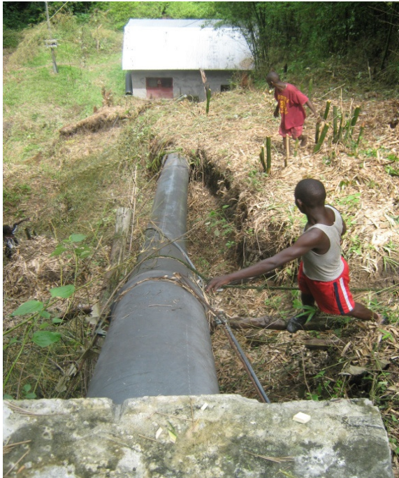
Σχήμα 5.41 Αγωγός πτώσης χωρίς εδαφική επικάλυψη (Πηγή: Politecnico di Bari, 2009)
