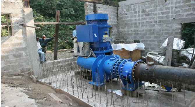
Σχήμα 5.34 Κεντρικός οικίσκος στη φάση κατασκευής (Πηγή: Politecnico di Bari, 2009)
