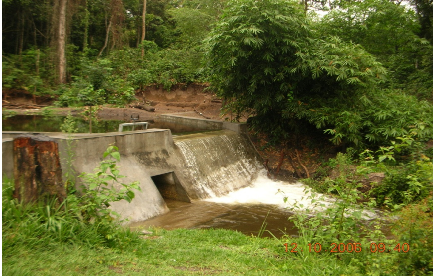
Σχήμα 5.13 Ο υπερχειλιστής του Nzasi με κλειστό θυρόφραγμα (Πηγή: Politecnico di Bari, 2009)
