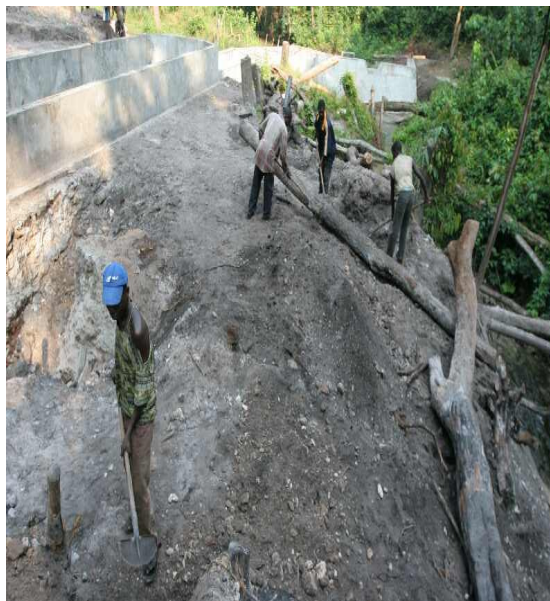
Σχήμα 5.24 Εκσκαφή δίπλα από τον εξαμμοτή για την εγκατάσταση των εκκενωτών πυθμένα
