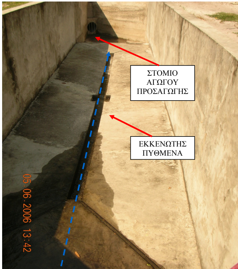
Σχήμα 5.25 Λεπτομέρεια εξαμωτή (Πηγή: Politecnico di Bari, 2009)
