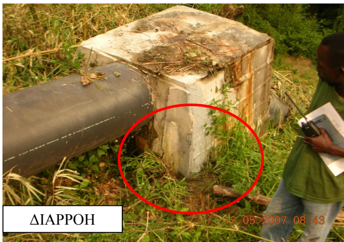
Σχήμα 5.45 Διαρροή στη θέση 1 (Πηγή: Politecnico di Bari, 2009)
