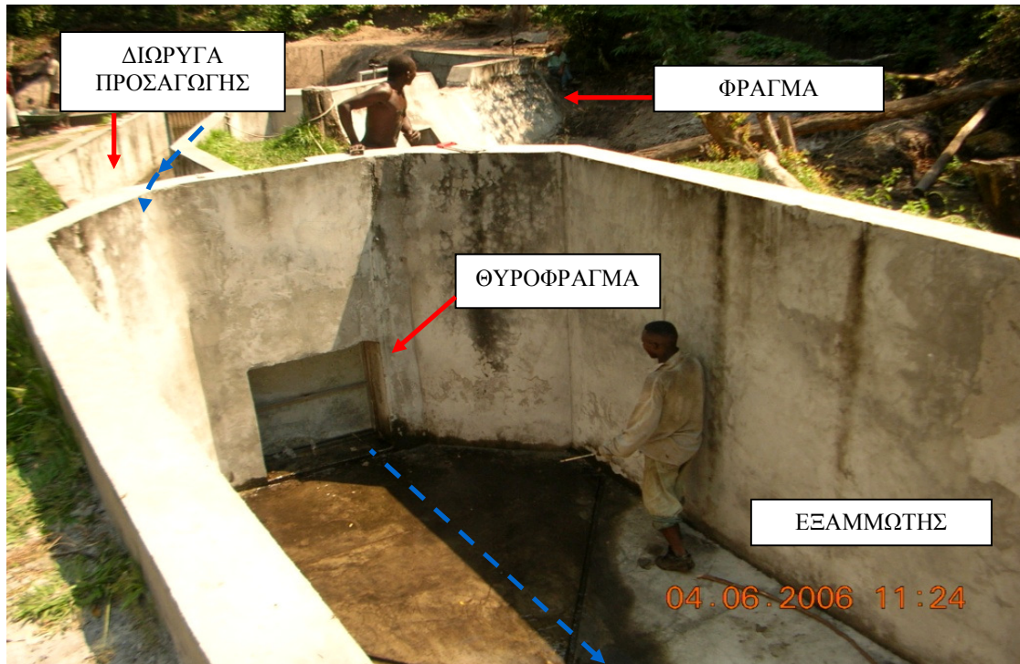
Σχήμα 5.22 Θυρόφραγμα και εξαμμώτης (Πηγή: Politecnico di Bari, 2009)
