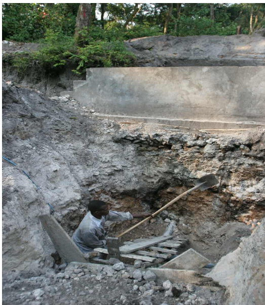
Σχήμα 5.23 Εκσκαφή δίπλα από τον εξαμμοτή για την εγκατάσταση των εκκενωτών πυθμένα
