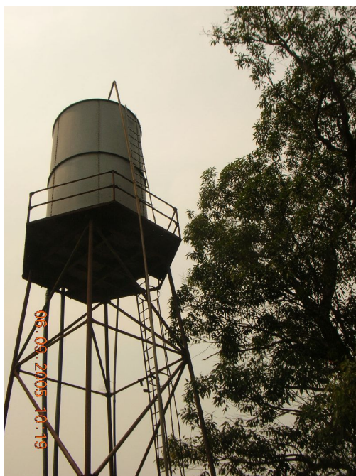
Σχήμα 5.38 Υδατόπυργος (Πηγή: www.kimbau.org )
