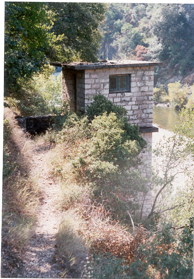
Φ.10 ΠΟΡΟΣ ΡΗΓΑΝΙΟΥ: ΛΕΠΤΟΜΕΡΕΙΑ: Κτίσμα σταθμηγράφου
