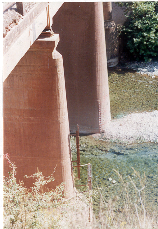
Φ.12 ΠΟΡΟΣ ΡΗΓΑΝΙΟΥ ΛΕΠΤΟΜΕΡΕΙΑ: Σταθμήμετρα στα βάθρα της Γέφυρας
