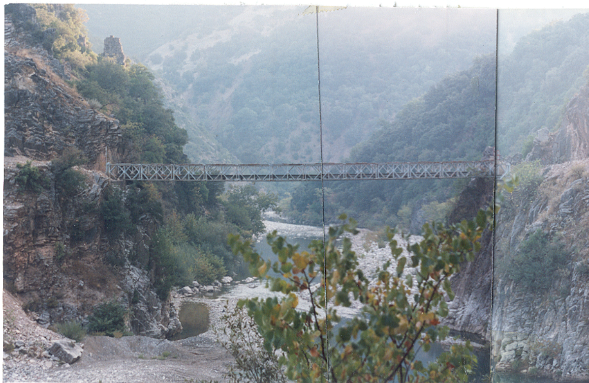
Φ.16 Γέφυρα Αρτοτίβας. Όψη από Ανάντη
