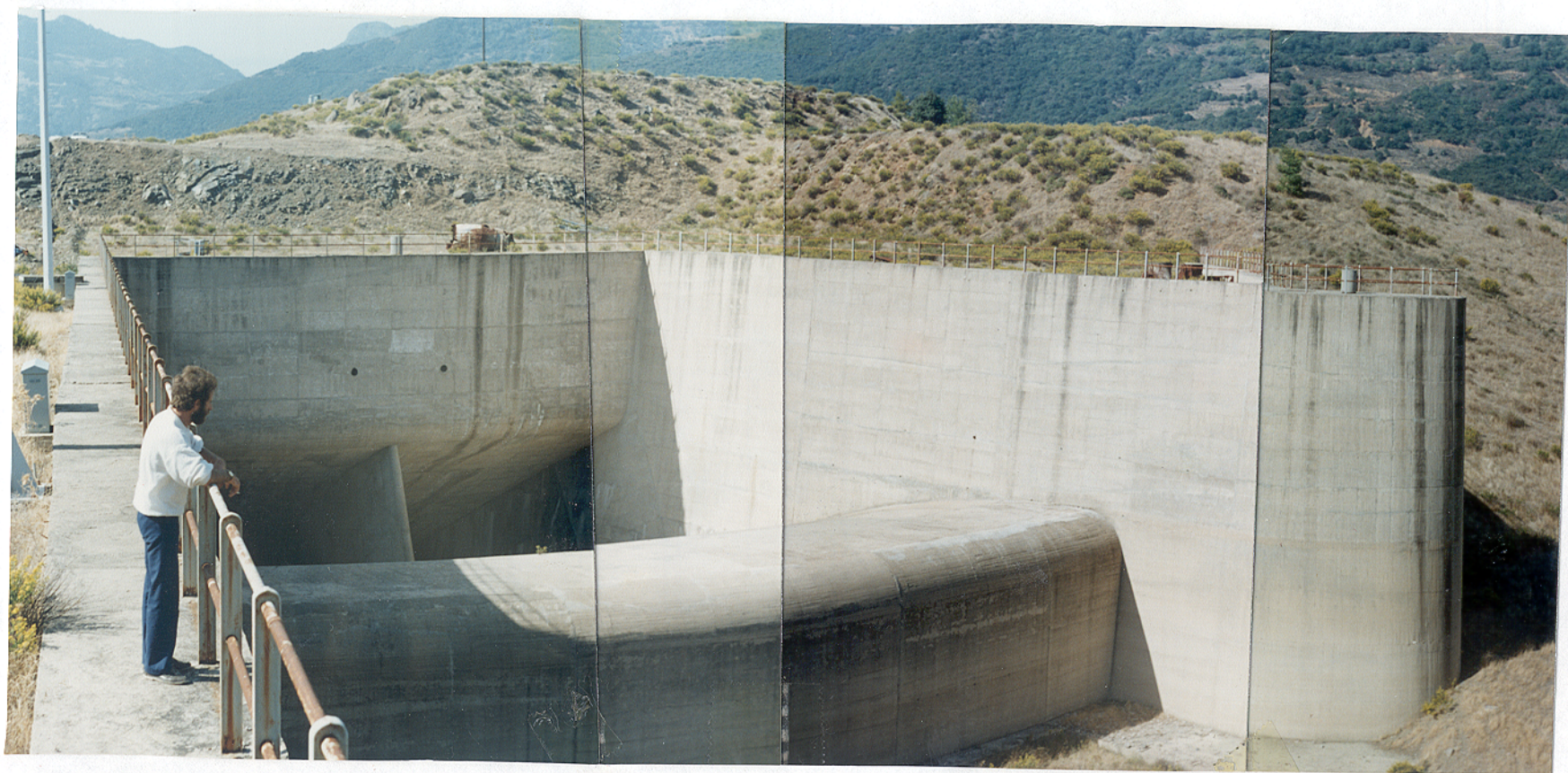
Φ.3 ΦΡΑΓΜΑ ΜΟΡΦΟΥ: ΥΠΕΡΧΕΙΛΙΣΤΗΣ - ΕΡΓΟ ΕΙΣΟΔΟΥ
