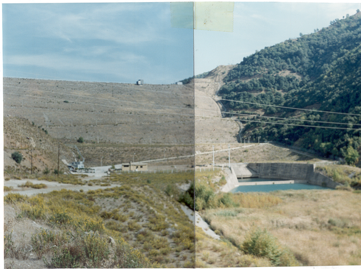
Φ.4 ΦΡΑΓΜΑ ΜΟΡΝΟΥ: ΕΡΓΟ ΕΞΟΔΟΥ ΥΠΕΡΧΕΙΛΙΣΤΗ, ΚΑΙ ΕΚΚΕΝΩΤΗ ΠΥΘΜΕΝΑ
