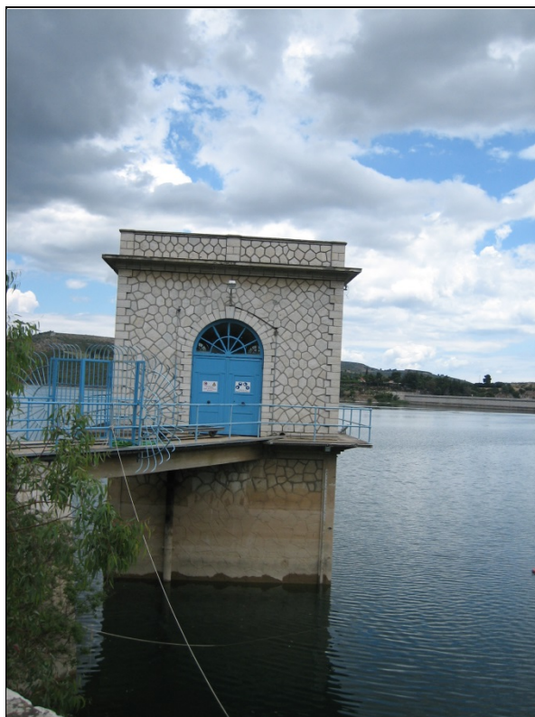
Εικόνα 10: Ο πύργος υδροληψίας του ταμιευτήρα Μαραθώνα.
