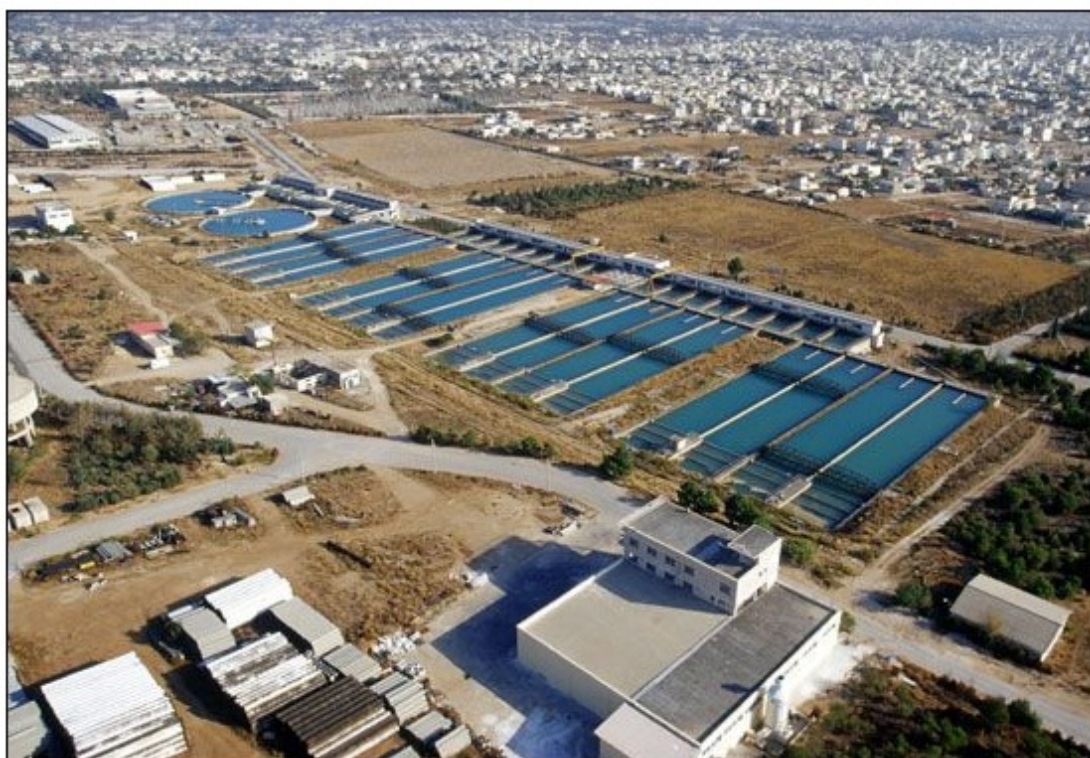
Εικόνα 7: Μονάδα επεξεργασίας Νερού Αχαρνών Πηγή: Φωτογραφικό Αρχείο ΕΥΔΑΠ
