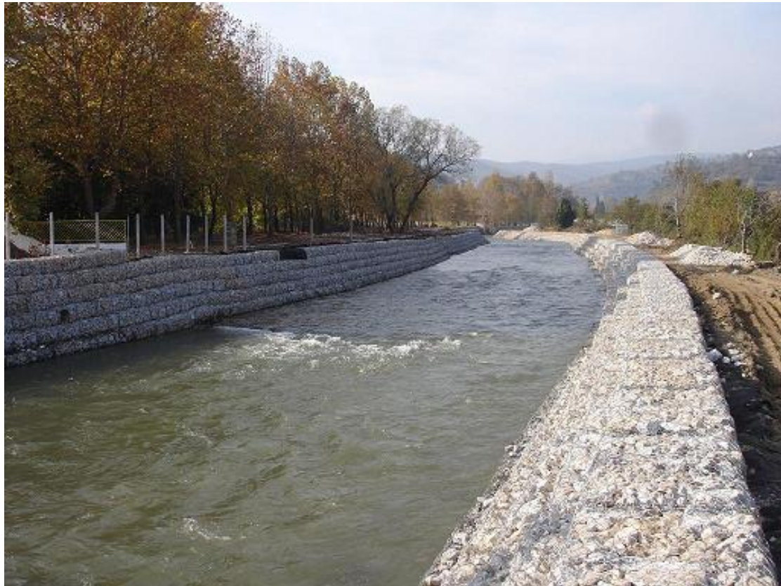
Εικόνα 24: Χρήση συρματοκιβωτίων για τη διευθέτηση της ροής ποταμού.
