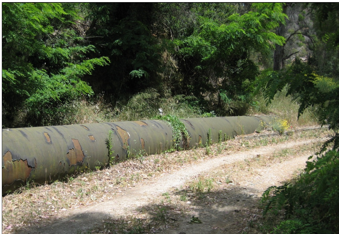
Εικόνα 11: Ο αγωγός μεταφοράς νερού από τον ταμιευτήρα του Μαραθώνα προς το κωπηλατοδρόμιο του Σχινιά, καθώς διέρχεται κατά μήκος του ρέματος της Οινόης.
