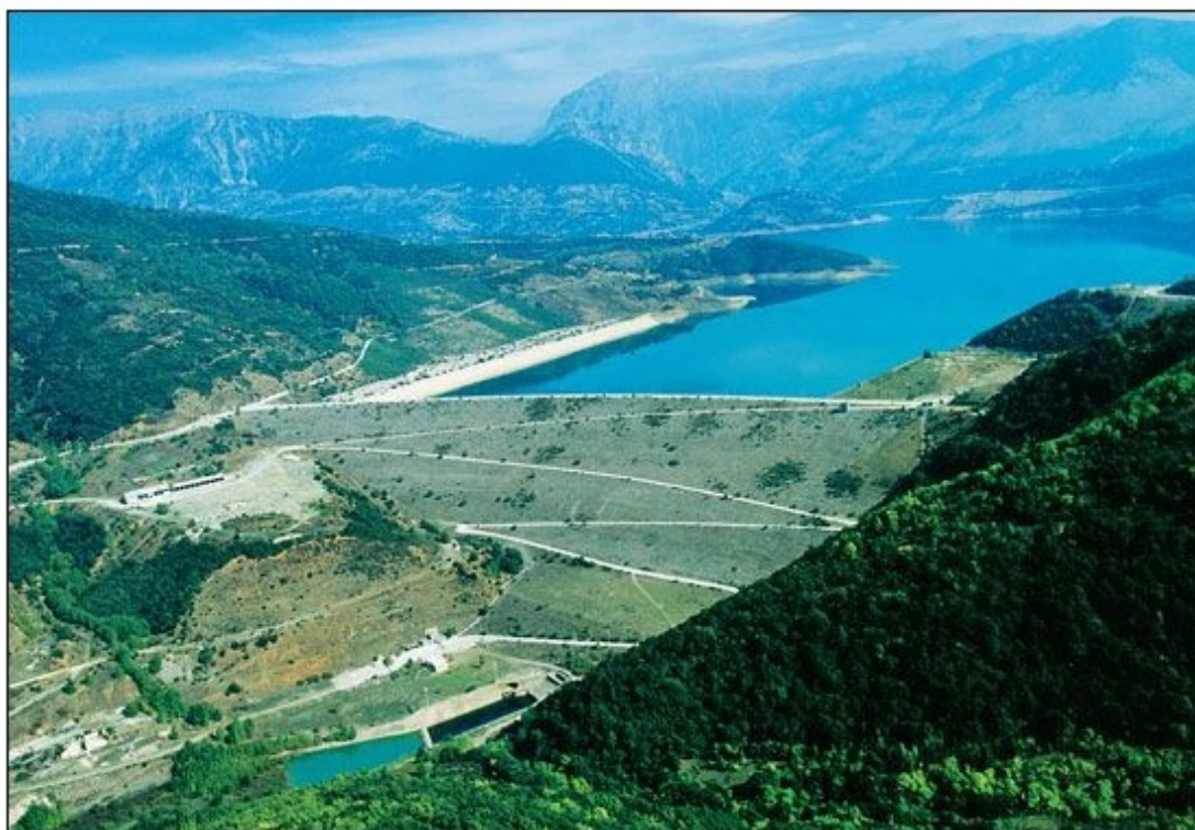
Εικόνα 5: Το φράγμα του Μόρνου Πηγή: Φωτογραφικό Αρχείο ΕΥΔΑΠ
