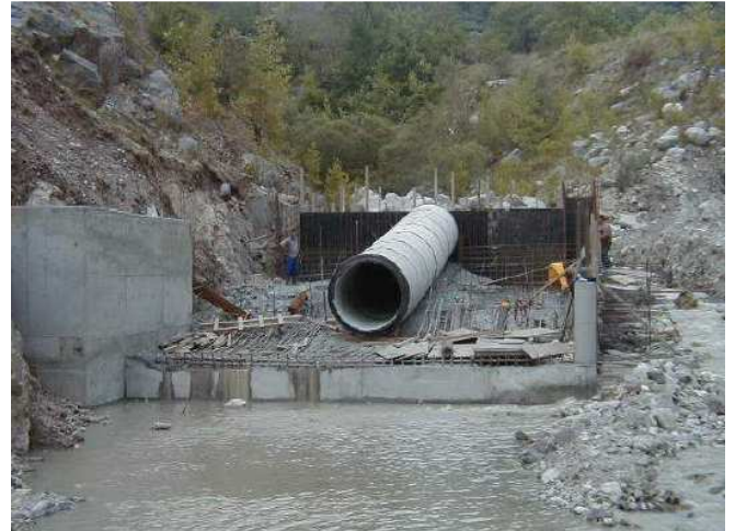
ΓΚΟΥΡΑΣ κατασκευή υδροληψίας
