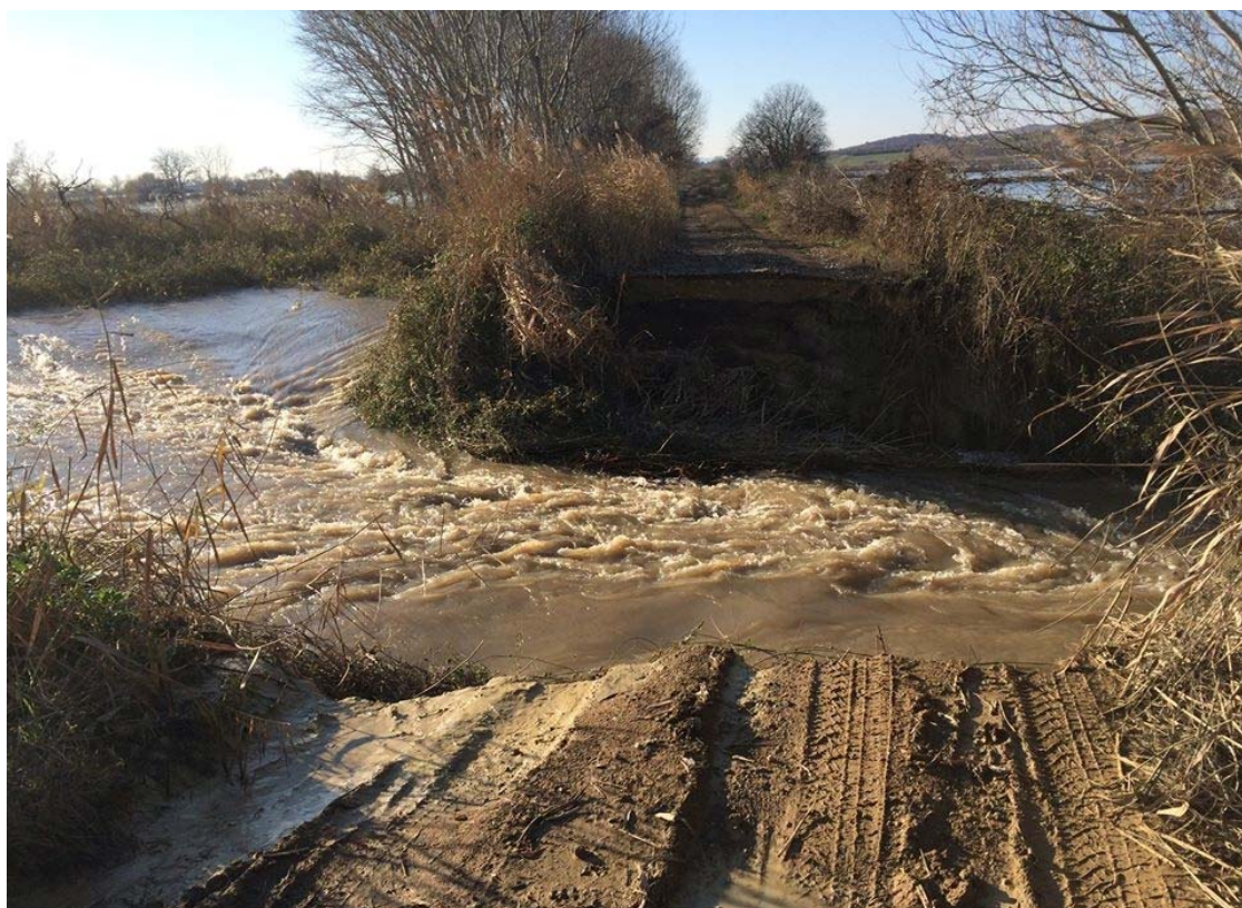
Σχήμα 5.5: Σπάσιμο αναχώματος στη Γεμιστή, 13/12/2014
