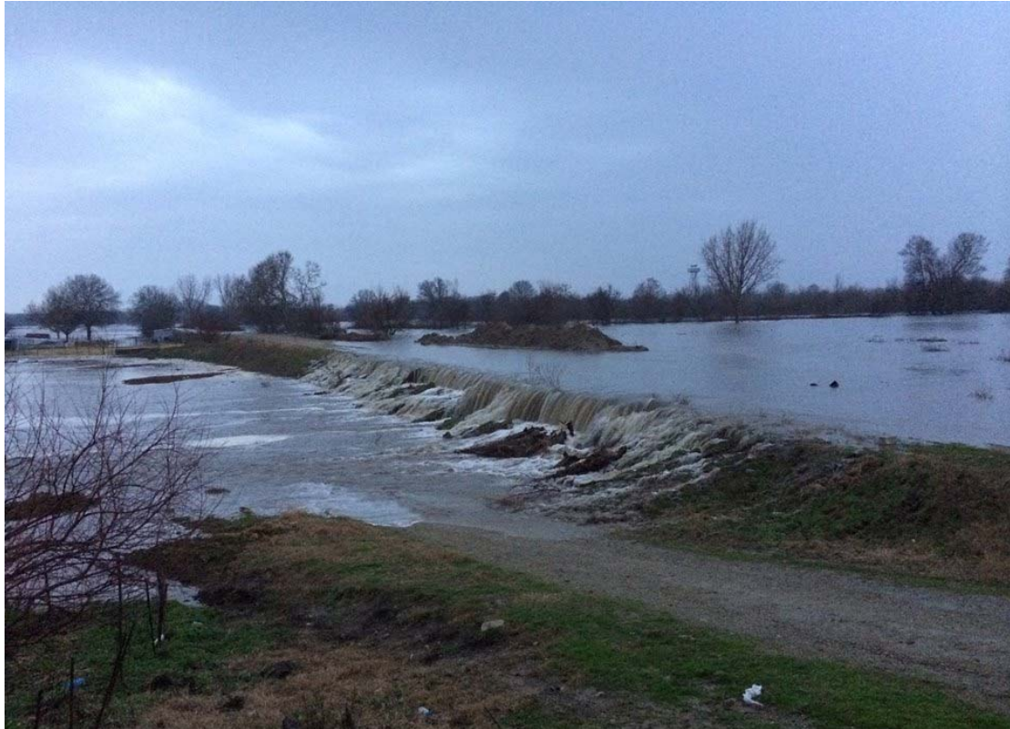
Σχήμα 5.6: Υπερβλητό ανάχωμα Πόρου κατά τις πλημμύρες του 2014
