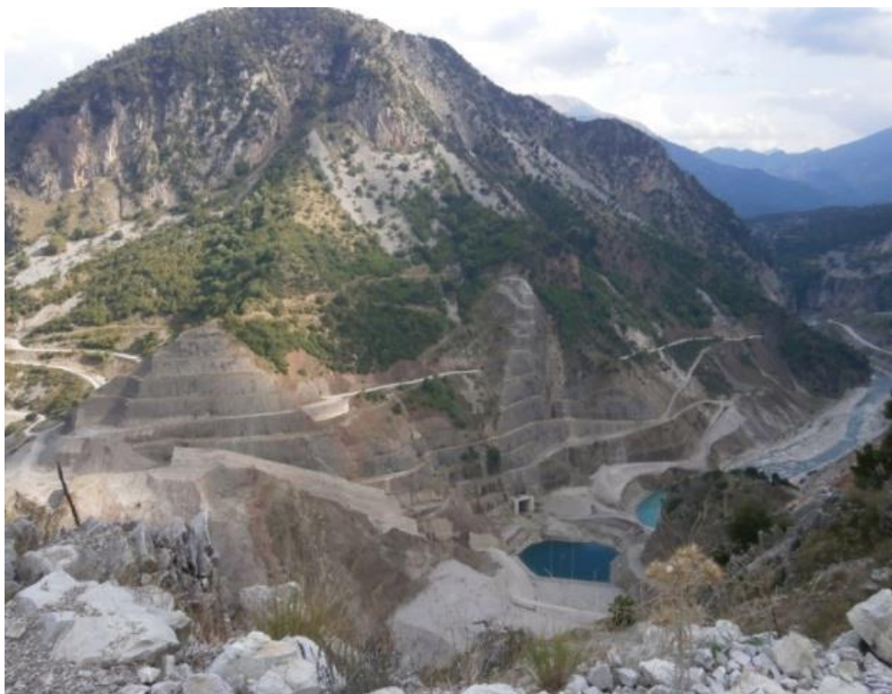
Εικόνα 32 Φράγμα Συκιάς (σήμερα) ο εκχειλιστής από Σκυρόδεμα και στο βάθος η σήραγγα εκκένωσης Ταμιευτήρα
