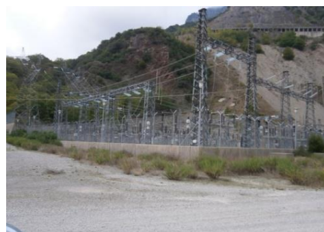
Εικόνα 29: Σταθμός παραγωγής Γλύστρας σήμερα
