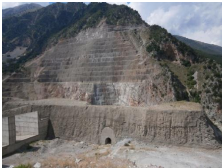
Εικόνα 32 Η κεφαλή, το κατώφλι του εκχειλιστή
