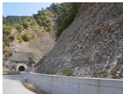
Εικόνα 24: Η ανατολική είσοδος στο Φράγμα (από Μεσοχώρα)
