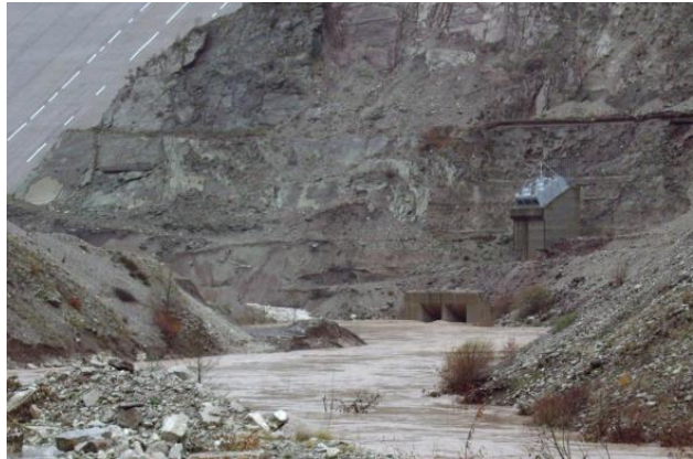
Εικόνα 21: Είσοδος σήραγγας εκτροπής
