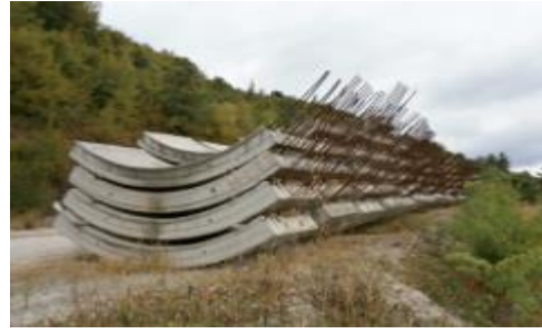
Εικόνα 38 : Προκατασκευασμένα κελύφη επένδυσης σήραγγας εκτροπής
