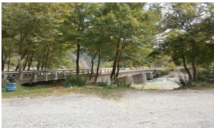
Εικόνα 31 Η νέα γέφυρα στον Αχελώο στο όριο των νομών Καρδίτσας Άρτας
