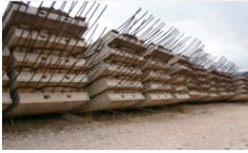
Εικόνα 38 : Προκατασκευασμένα κελύφη επένδυσης σήραγγας εκτροπής
