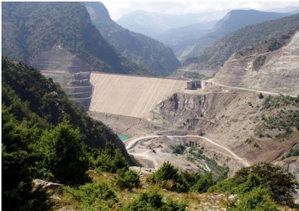
Εικόνα 20: Γενική άποψη Φράγματος Μεσοχώρας (2005)
