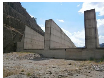
Εικόνα 32 Η κεφαλή, το κατώφλι του εκχειλιστή
