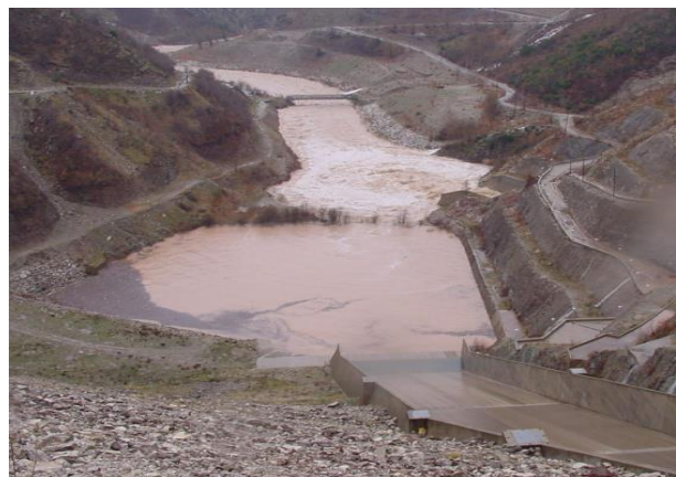
Εικόνα 22: Εξόδος σήραγγας εκτροπής
