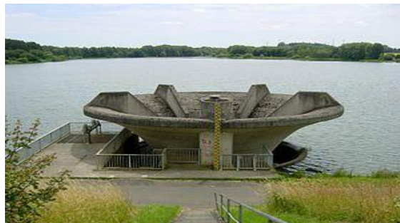
Εικόνα 89: Φράγμα Antrift-υπερχειλιστής
