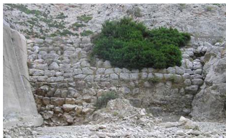
Εικόνα 31: Κατάντη όψη του φράγματος Αλυζίας
