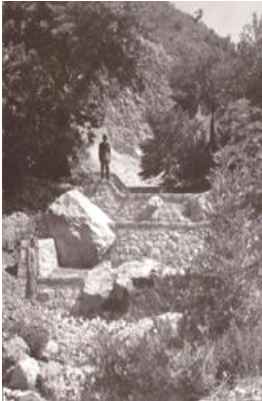
Εικόνα 34: Ενσωματωμένος βράχος στο φράγμα
