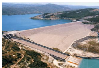
Εικόνα 47: Φράγμα Πουρναρίου I
