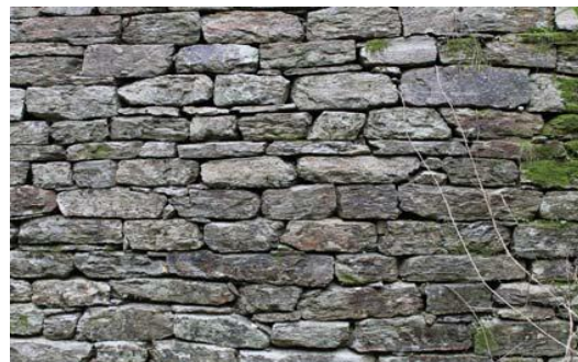
Εικόνα 33: Ξηρολιθίνο τοίχιο φράγματος ανάσχεσης
