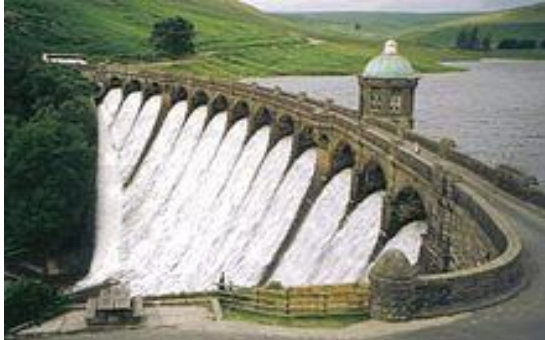
Εικόνα 70: Φράγμα Craig Goch (εικ.65, 66)
