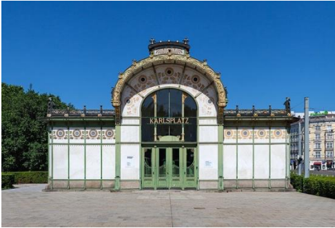
Εικόνα 22: Otto Wagner Σιδηροδρομικός σταθμός Karlsplatz στη Βιέννη
