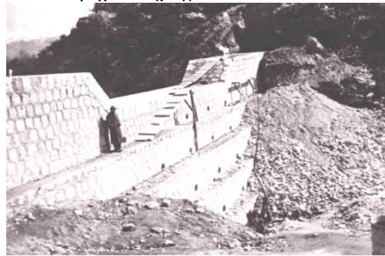
Εικόνα 36: Υπό κατασκευή φράγμα ανάσχεσης
