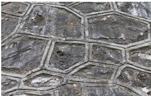
Εικόνα 32: Λιθόδομητο τοίχιο φράγματος ανάσχεσης
