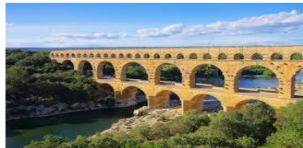
Εικόνα 6:Υδραγωγείο Pont du Gard
