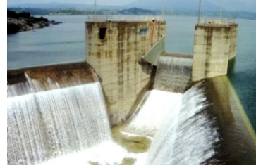
Εικόνα 61: Φράγμα Πηγειού Ηλείας
