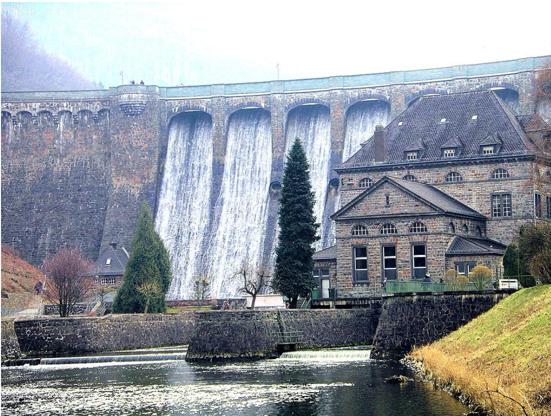
Εικόνα 73:Φράγμα Diemel α:Υπερχείλιση και σταθμός ηλεκτρικής ενέργειας
