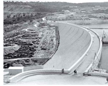
Εικόνα 57: Κατασκευή φράγματος Μαραθώνα. 1930
