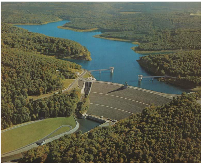
Εικόνα 90: Πανοραμική άποψη φράγματος Gileppe
