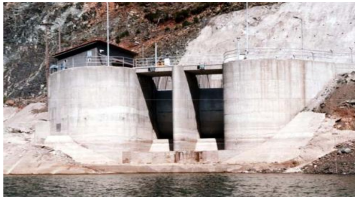
Εικόνα 4.5: Εκχειλιστής και θυροφράγματα του ΥΗΣ Πηγών Αώου
