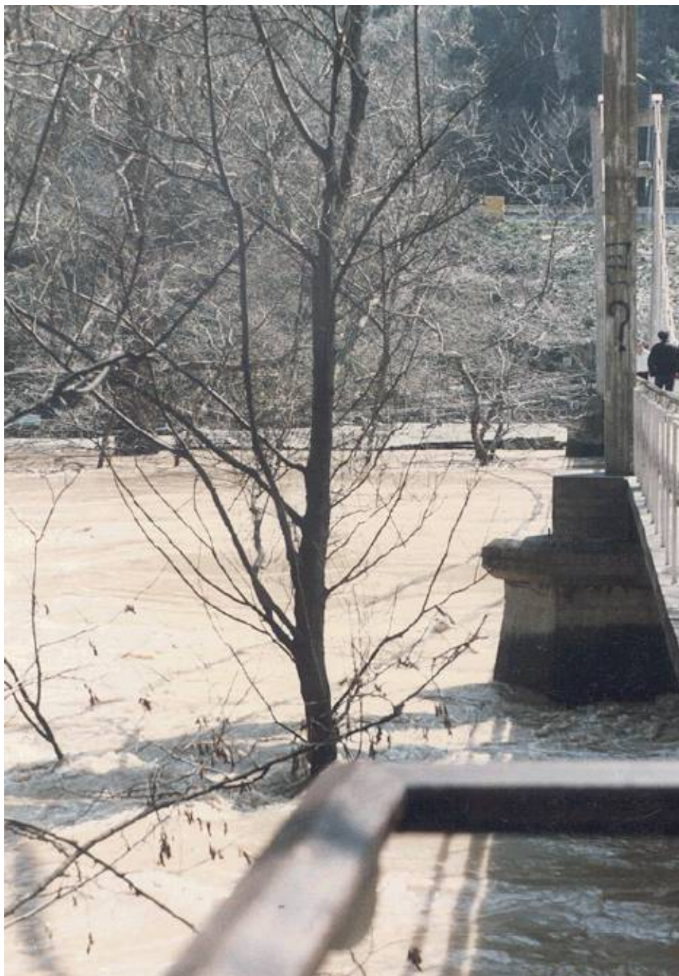
Σχ. 7: Η πλημμύρα του Πηνειού του Μαρτίου 1987 που μετρήθηκε από τους κκ. Σωτήρη Μπελούκα και Μάρκο Θάνο (Υπουργείο Γεωργίας) σε διάφορες θέσεις κατά μήκος του Πηνειού με παροχές που ξεπέρασαν τα 1000 κυβικά μέτρα ανά δευτερόλεπτο. Στη φωτογραφία η πλημμύρα στην πεζογέφυρα των Τεμπών στις 26 Μαρτίου 1987. Η μέγιστη στάθμη έφτασε τα 8 μέτρα και η παροχή τα 1000 κυβικά μέτρα ανά δευτερόλεπτο. (Φωτογραφία Σ. Μπελούκα).
