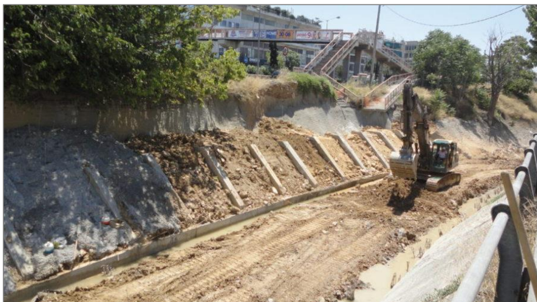
Εικόνα 3-4: Έργα στην κοίτη του Κηφισού, στο ύψος της οδού Λάμπρου Κατσώνη (Πηγή: https://politisfx.gr/2017/07/22/i-poreia-ton-ergon-ston-kifiso/ )
