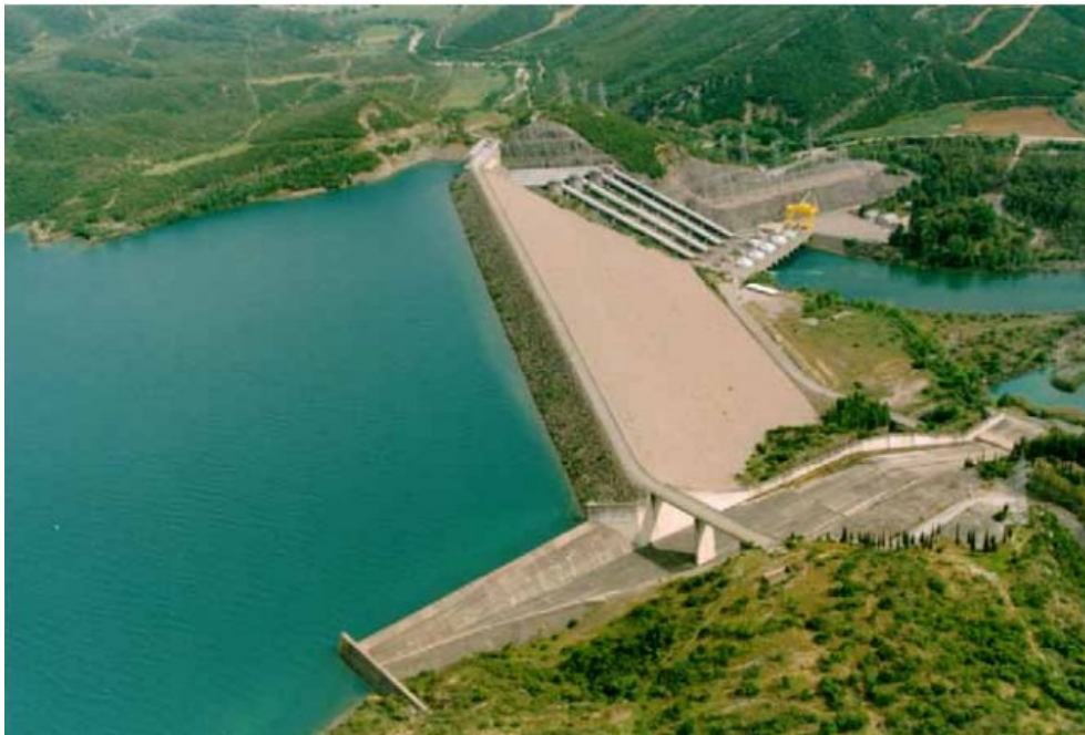
Εικόνα 4.2: Άποψη φράγματος Καστρακίου (Πηγή: Ελληνική Επιτροπή Μεγάλων Φραγμάτων)
