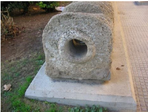
Πέτρα αγκύρωσης του μολύβδινου αγωγού υπό πίεση
