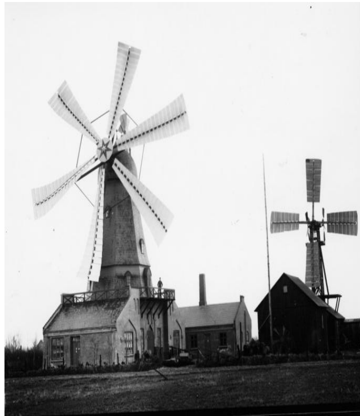
Ο ανεμόμυλος P. La Cour στη Δανία, 1890. Τοπικός σταθμός ηλεκτροπαραγωγής του χωριού Askov. Οριζόντιου άξονα
