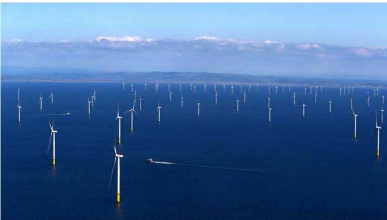
Εικόνα 46: Το πλωτό αιολικό πάρκο στο Walney της Αγγλίας. Το μεγαλύτερο πλωτό αιολικό πάρκο. [68]
