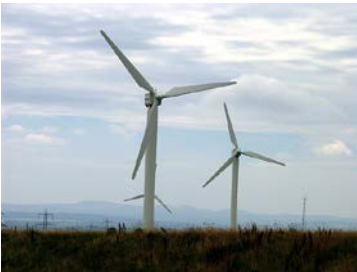
Εικόνα 30: Το αιολικό πάρκο Delabole στο Cornwall. [41]
