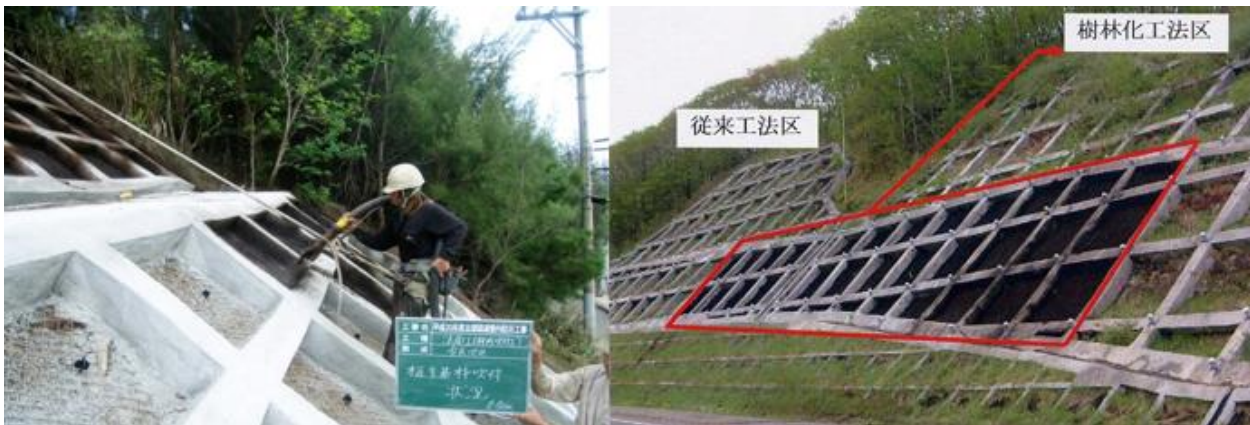
Εικόνα 4. Φωτογραφίες από τη διαδικασία κατασκευής των κυπελοειδών κανάβων συγκράτησης εδάφους..
