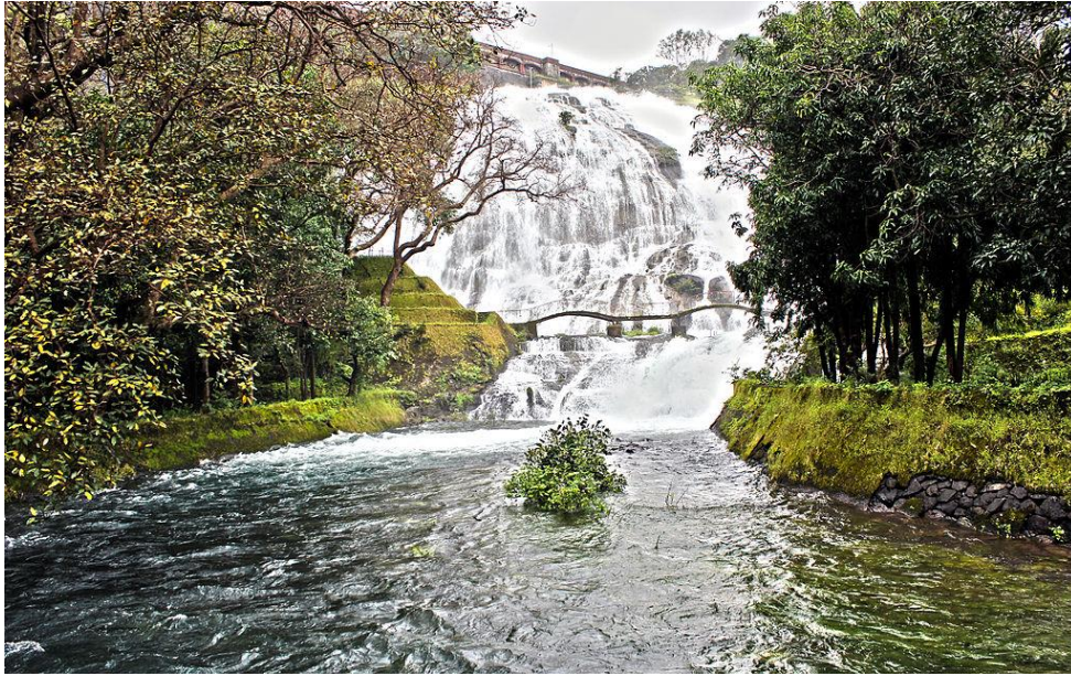
Εικόνα 3. Φράγμα Wilson. Φωτογραφία από κατάντη του φράγματος προς το φράγμα κατά την εκχείλιση. Πηγή: www.en.wikipedia.org
