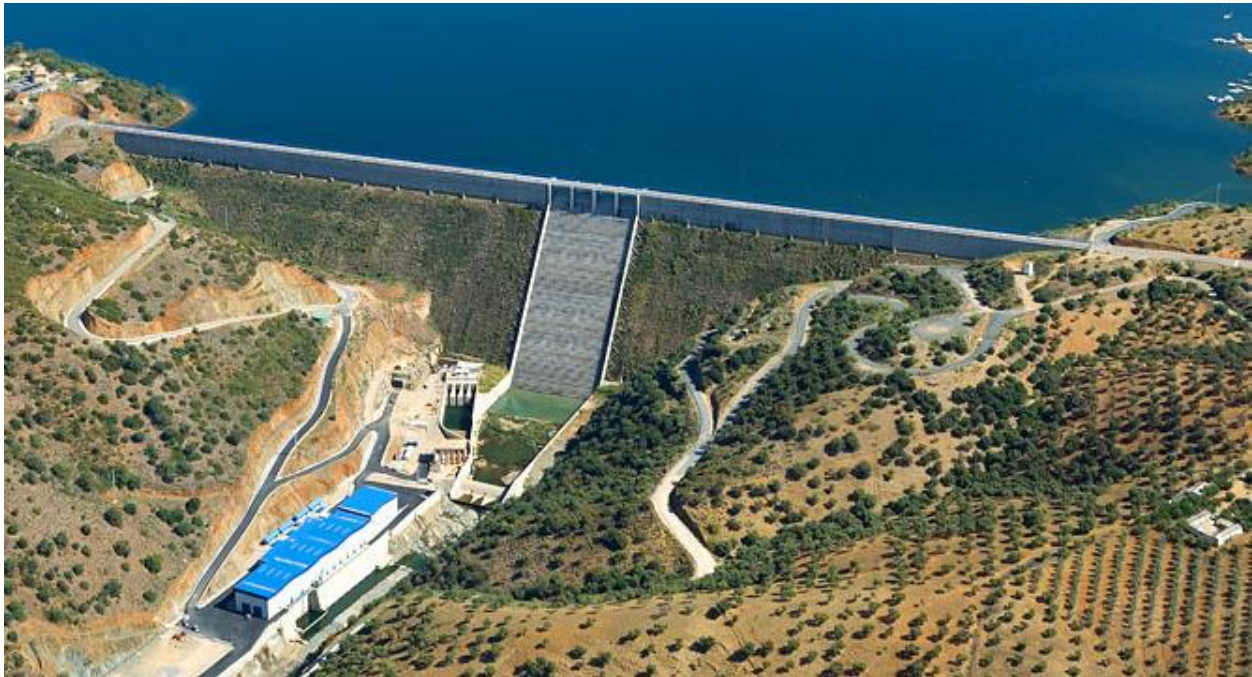
Εικόνα 2. Φράγμα La Brena II. Αεροφωτογραφία του κατάντη πρανού του φράγματος. Πηγή: www.dragados-usa.com .
