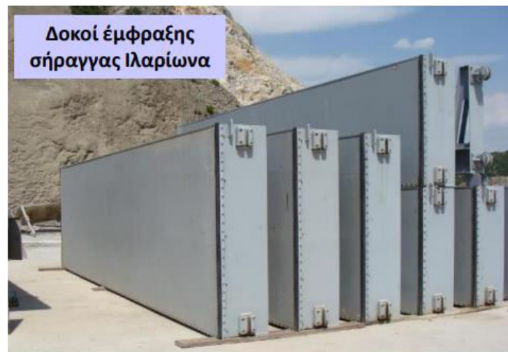
Εικόνα 4.1 Δοκοί προσωρινής έμφραξης σήραγγας εκτροπής
