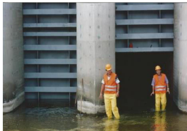
Εικόνα 4.2 Έμφραξη σήραγγας εκτροπής σήραγγας Σμόκοβου (2002)
