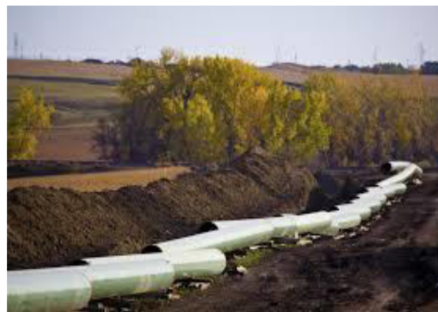
Εικόνα 4.14β Τοποθέτηση μεταλλικού αγωγού σε όρυγμα
