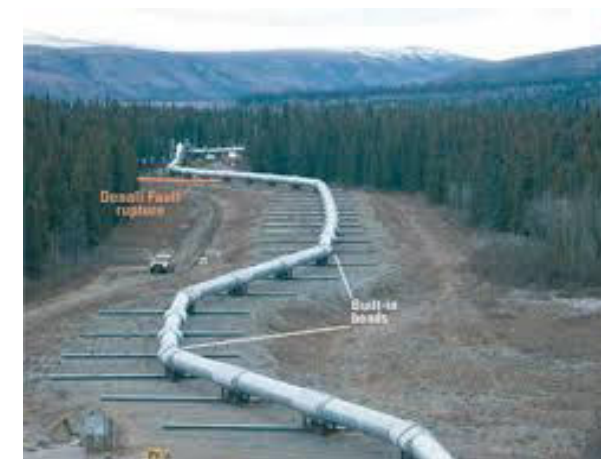
Εικόνα 4.15 Επίλυση διασταύρωσης αγωγού με ενεργό ρήγμα (Αγωγός πετρελαίου στο Denali, Αλάσκα)
