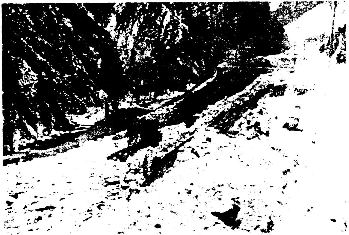
Φ4: Ζώνη απόθεσης ακατάλληλων υλικών εκσκαφής ( 100000 \text{ m}^3 ), μήκους 800m, 1,5 Km περίπου κατάντη του φράγματος Μεσοχώρας, παραπλεύρως και μερικώς εντός της κοίτης του Αχελώου. Ομοίως ισχυρές επιπτώσεις όπως παραπάνω.
