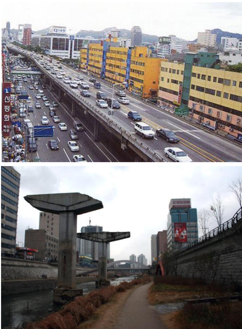
Σχ. 3 Παράδειγμα αστικής ανάπτυξης στη Seoul, Νότια Κορέα. Στην πάνω φωτογραφία (2001) φαίνεται ο αυτοκινητόδρομος Cheonggye τεσσάρων λωρίδων που κατασκευάστηκε την περίοδο 1967 - 71, πάνω από έναν κανονικό δρόμο κατά μήκος της κοίτης του ρέματος Chonggyecheon, μήκους 10 km με λεκάνη απορροής 50 km 2 . Στην κάτω φωτογραφία (2005) φαίνεται η κατάσταση μετά την αστική ανάπτυξη, με καθαίρεση όλων των οδικών έργων, αποκάλυψη του ρέματος και δημιουργία πάρκου αναψυχής. Ορισμένα από τα βάρθρα δεν καθαιρέθηκαν για λόγους ιστορικής μνήμης. (Πηγή: Seoul, South Korea, Cheonggye Freeway 5 ).
