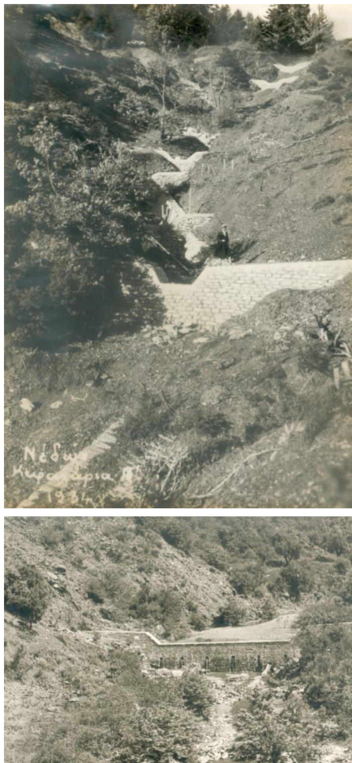
Σχ. 33. Φωτογραφίες ενδεικτικές της μείωσης της φυσικής κλίσης του Νέδοντα λόγω της κατασκευής των αναβαθμών. (Αρχείο τοπικής Δασικής Υπηρεσίας, ευγενική χορηγία Β. Χαντζή.)
