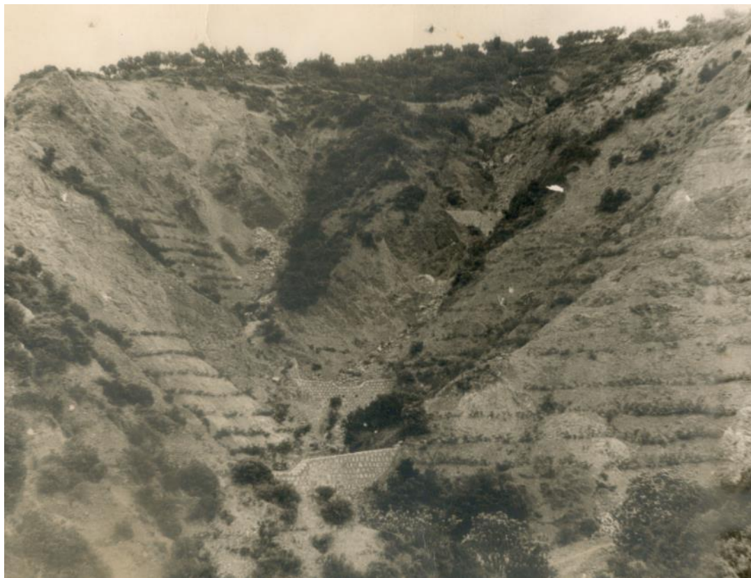
Σχ. 11. Φωτογραφίες από ξηρολίθινες αναβαθμίδες για την προστασία της λεκάνης του Νέδοντα από τη διάβρωση. (Αρχείο τοπικής Δασικής Υπηρεσίας, ευγενική χορηγία Β. Χαντζή.)
