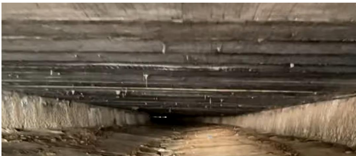
Σχ. 14. Φωτογραφία του τμήματος Γ της διευθετημένης και καλυμμένης κοίτης του Νέδοντα. Το τμήμα Ε είναι παρόμοιο. 17
