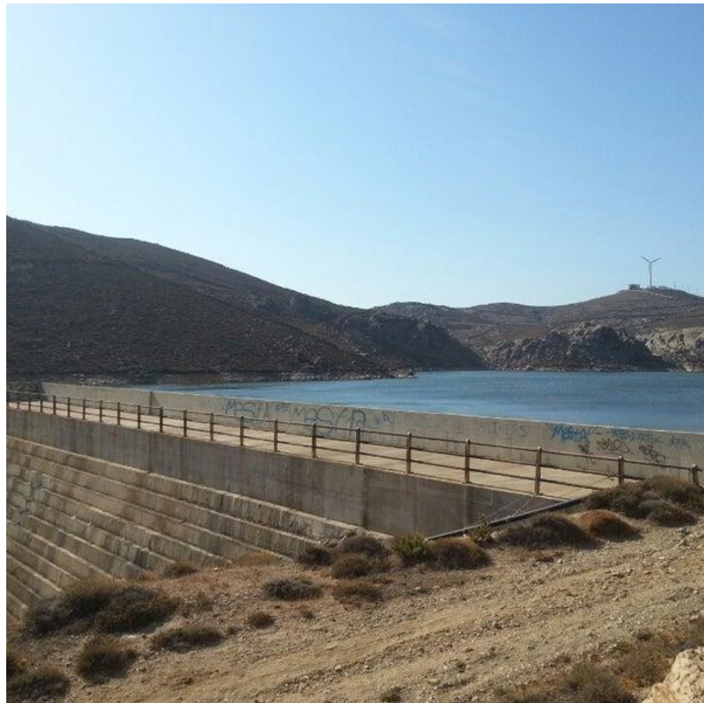
Εικόνα 6: Ταμιευτήρας Άνω Μεράς
