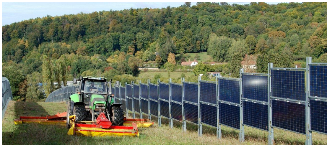
Εικόνα 2.7 Πιλοτικό σύστημα κάθετων αγροβολταϊκών στην Σουηδία (pv-magazine.com)
