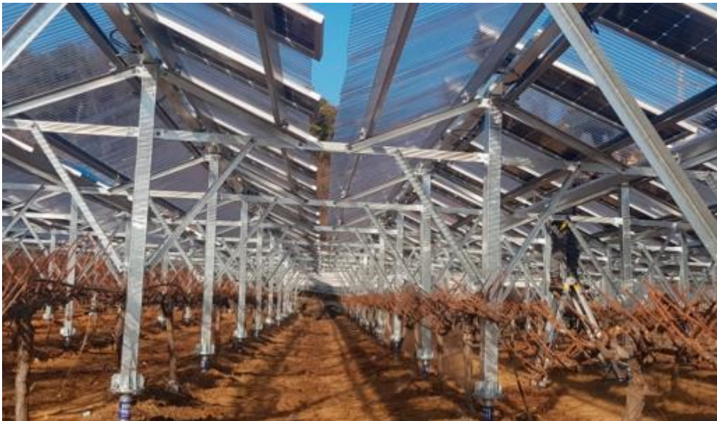
Εικόνα 2.11 Αγροβολταϊκά διπλής όψης σε σταφύλια, ενσωματωμένα σε εγκατάσταση που τα προστατεύει από την βροχή (Cho,2020)
