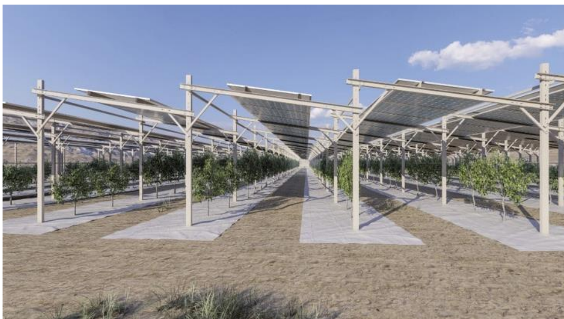
Εικόνα 2.10 Οπωροβολταϊκά διπλής όψης στο Ισραήλ, (pv-magazine.com)
