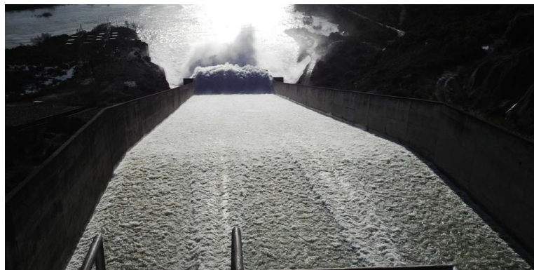
Εικόνα 3.14: Διόδευση από τον εκχειλιστή φράγματος Πουρναρίου Ι, Πλημμύρα 2015 (Roilos, 2018)
