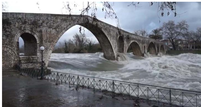
Εικόνα 3.16: Η γέφυρα της Άρτας κατά τη διέλευση της πλημμύρας της 1/2/2015 (Roilos, 2018)
