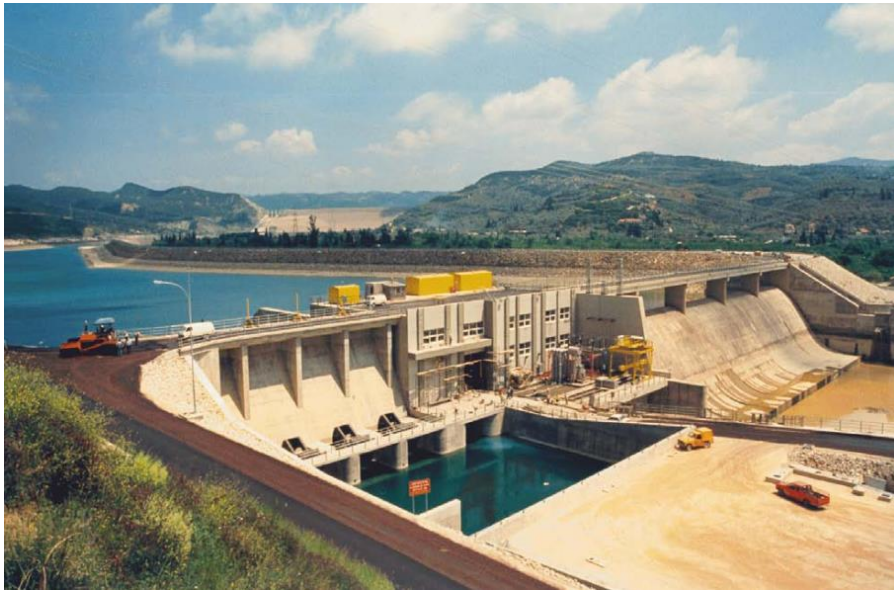
Εικόνα 3.12: Φράγμα Πουρναρίου II (Roilos, 2018)
