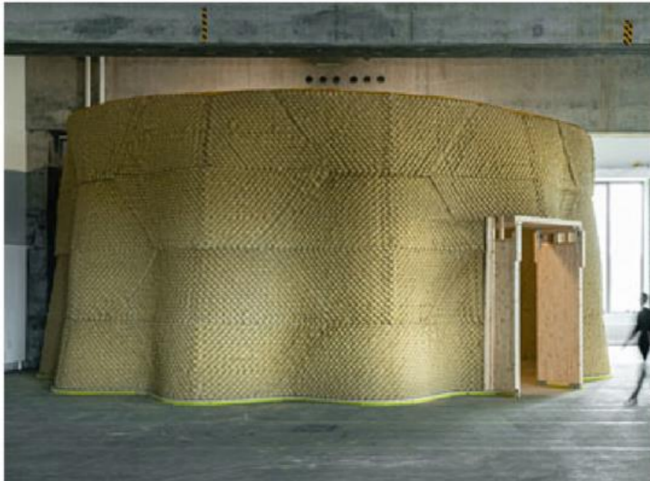
β. Ολοκλήρωση κτίσματος στο IAAC
