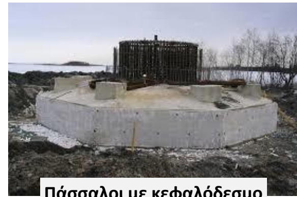
Πάσσαλοι με κεφαλόδεσμο
