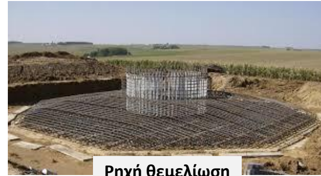
Ρηχή θεμελίωση
