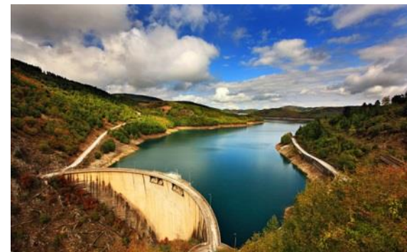
Ταμιευτήρας Πλαστήρα: ύδρευση, άρδευση, Υ/Η ενέργεια, τουρισμός
