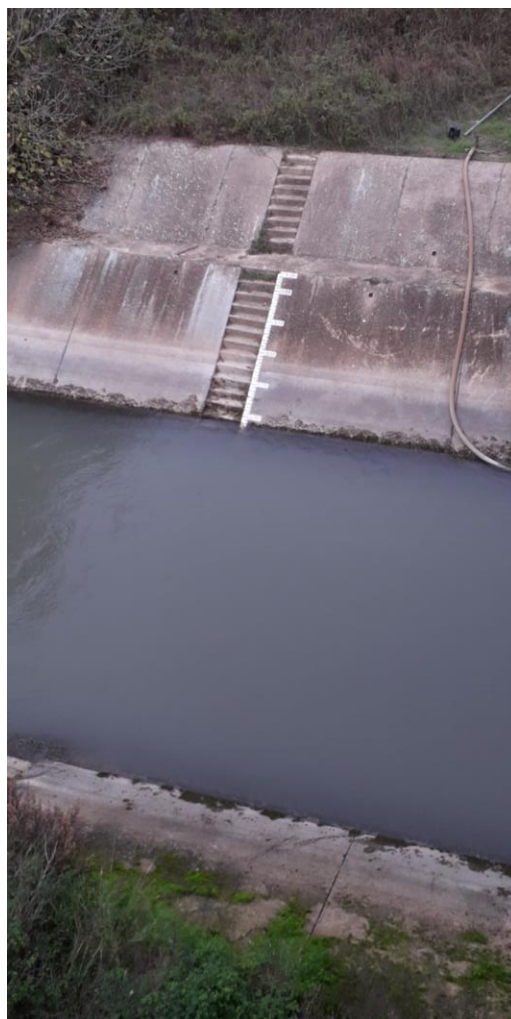
Κάτι σαν σταθμήμετρο (Διώρυγα Καρδίτσας, λίγο ανάντη της Υλίκης)
