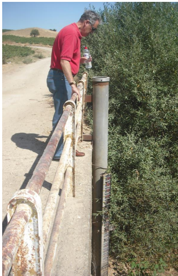
Συμβατικό σταθμήμετρο & σταθμηγράφος (Ασωπός)
