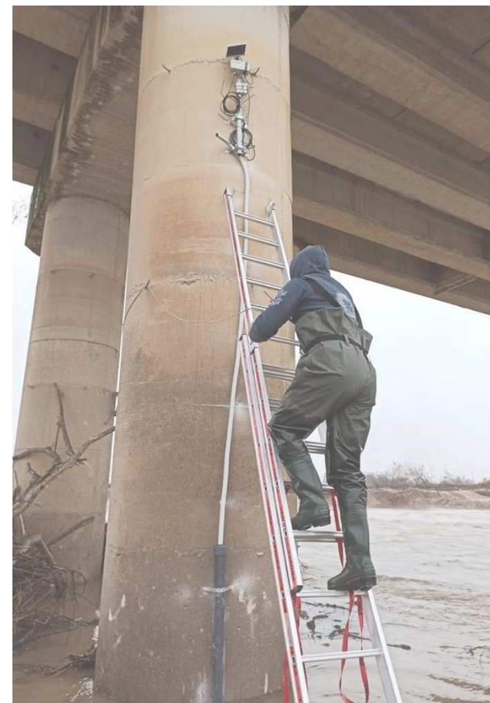
Εγκατάσταση αυτόματου σταθμηγράφου στον Πηνειό, κοντά στον οικισμό Νομή
