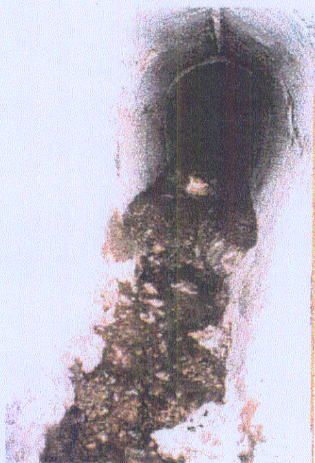
Φωτογραφία 4.6: Άποψη της απόθεσης επί της Ιεράπετρας
