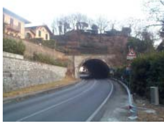
Εικόνα 5.7: Σύγκριση ορύγματος και εκσκαφής με επανεπίχωση Η αριστερή φωτογραφία είναι από τη λίμνη Πλαστήρα. Η δεξιά φωτογραφία έχει ληφθεί στη λίμνη του Como, Ιταλία, και είναι παράδειγμα εκσκαφής με επανεπίχωση (cut and cover).
