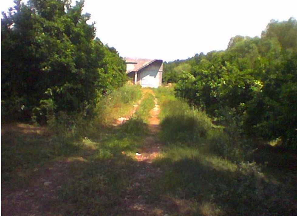
Φωτ. 2 Κτίσμα μέσα στο πεδίο πλημμυρών του Αχελώου. Η συνήθης κοίτη του ποταμού βρίσκεται ελάχιστα μέτρα στα δεξιά του κτίσματος.
