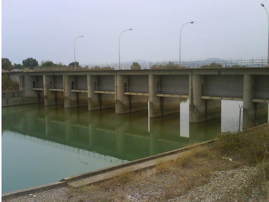
Φωτ. 3. Θυροφράγματα στο κατάντη άκρο της διώρυγας φυγής.
