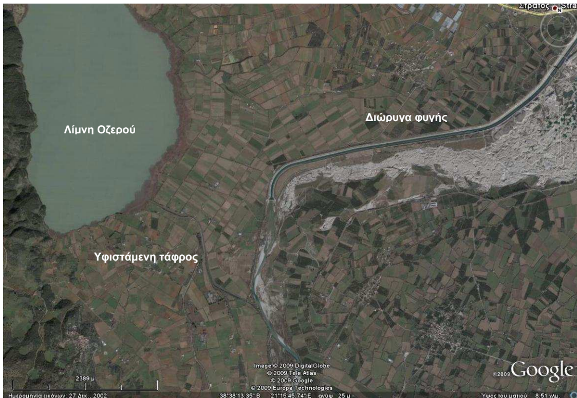
Φωτ. 5. Περιοχή εκβολής διώρυγας φυγής και λίμνη Οζερού
