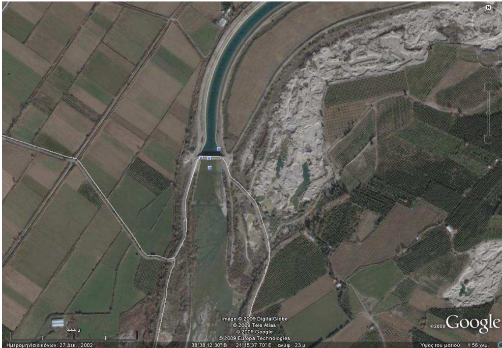
Φωτ. 6. Θέση εκβολής διώρυγας φυγής
