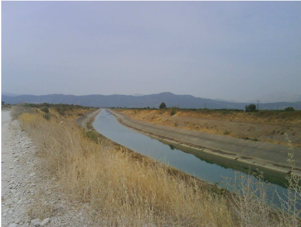
Φωτ. 2. Διώρυγα φυγής ΥΗΣ Στράτος I
