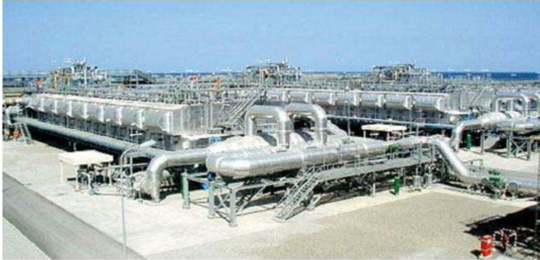
Σχήμα 3: Εγκατάσταση πολυβάθμιας εκτόνωσης στη Μέση Ανατολή
