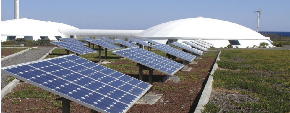
Σχήμα 38: Αυτόνομη Μονάδα Αφαλάτωσης Αντίστροφης Ωσμωσης στα Κανάρια Νησιά με φωτοβολταϊκά κελιά.
