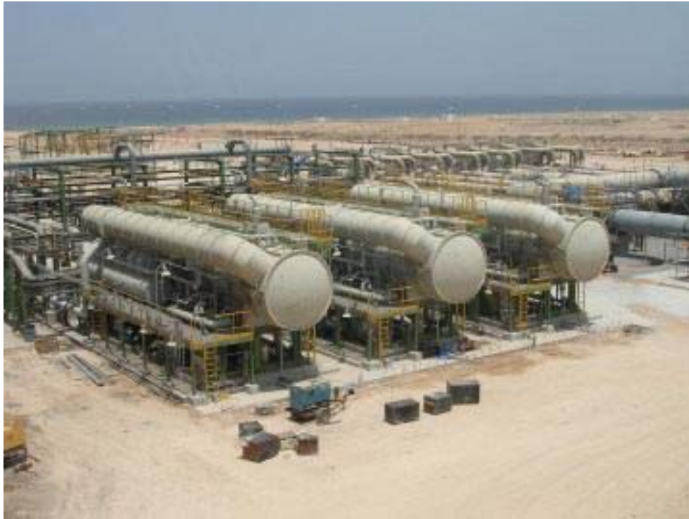
Σχήμα 5: Εγκατάσταση πολυβάθμιας εξάτμισης στο Ομάν (3 x 2400 m 3 /ημέρα)
