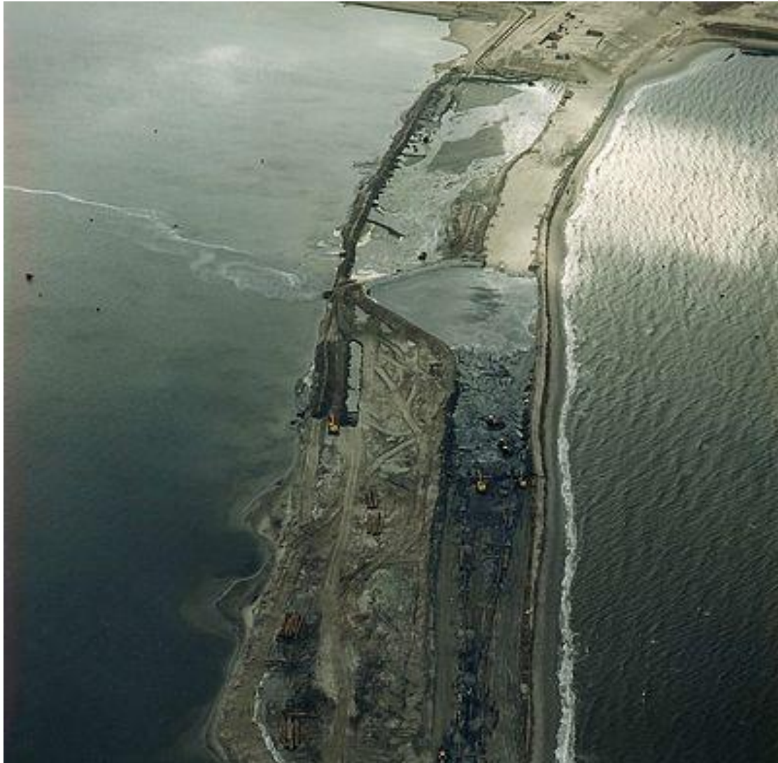
Εικόνα 147. Εργασίες κατασκευής φράγματος Philips.
