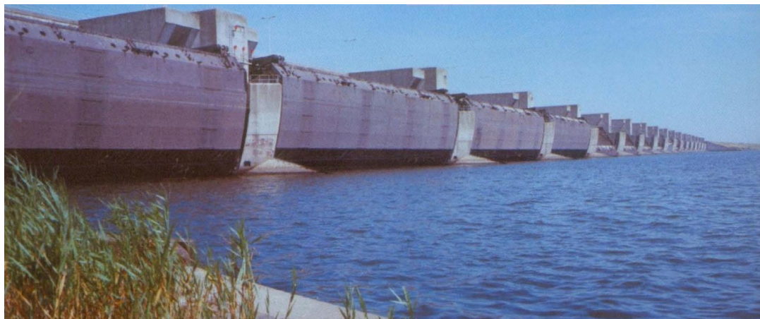
Εικόνα 97. Τα θυροφράγματα στο φράγμα Haringvliet.
