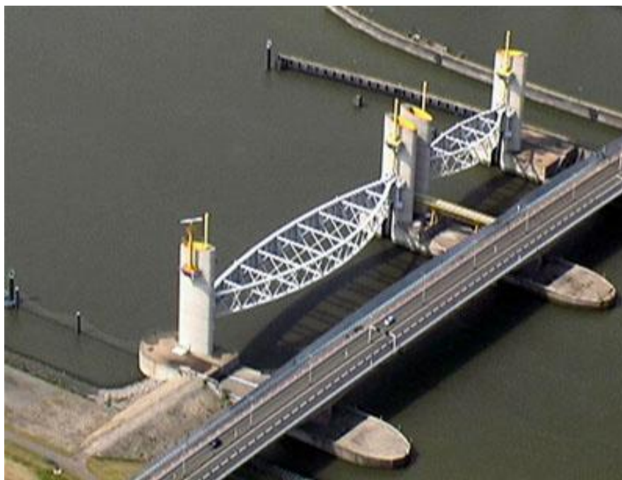
Εικόνα 130. Το φράγμα Hartel.
