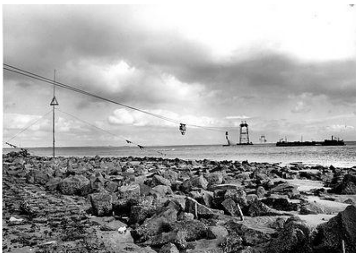
Εικόνα 85. Εγκατάσταση μεταφοράς υλικών κατασκευής.
