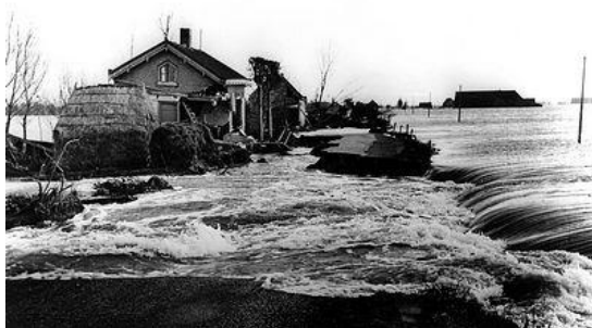
Εικόνα 48. Καταστροφή αναχώματος.
