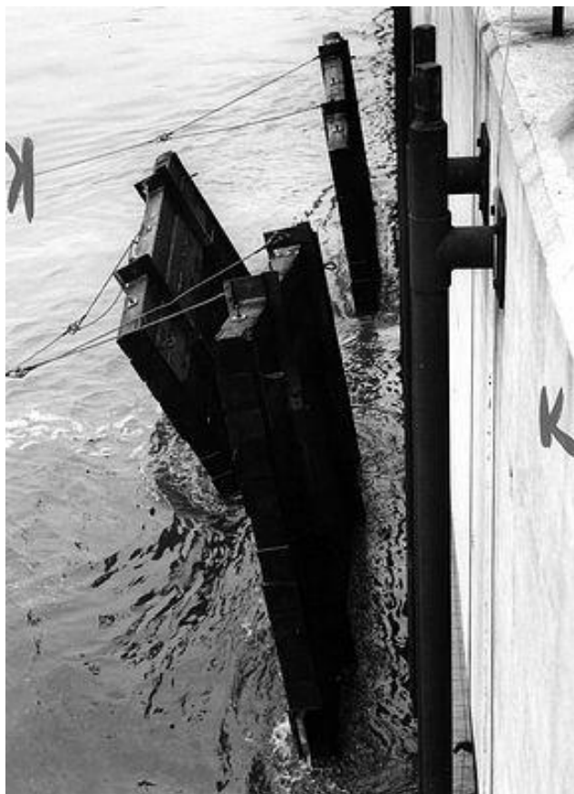
Εικόνα 110. Αφαίρεση στοιχείων που βοήθησαν στην κίνηση των τσιμεντένιων μπλοκ.
