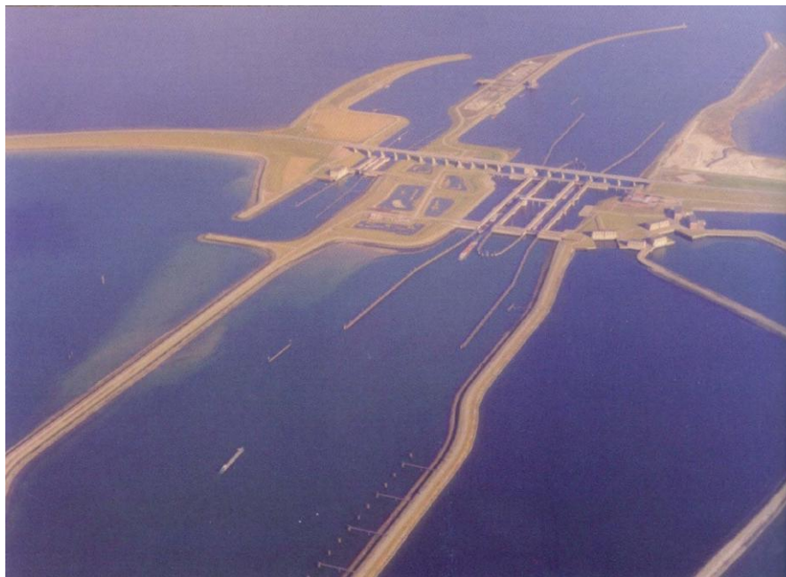
Εικόνα 146. Το φράγμα Philips.
