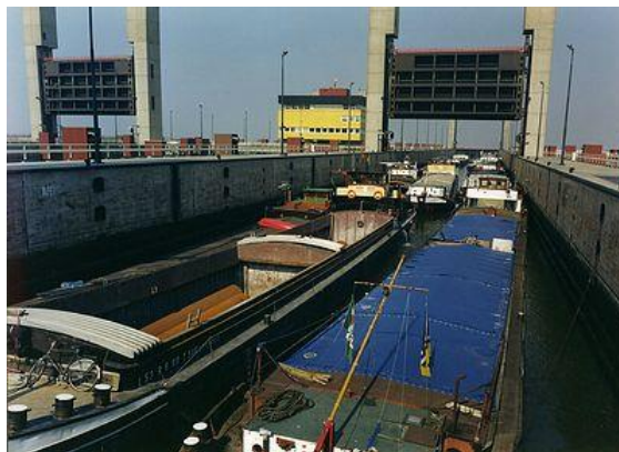
Εικόνα 143. Τα θυροφράγματα Kreekrak.
