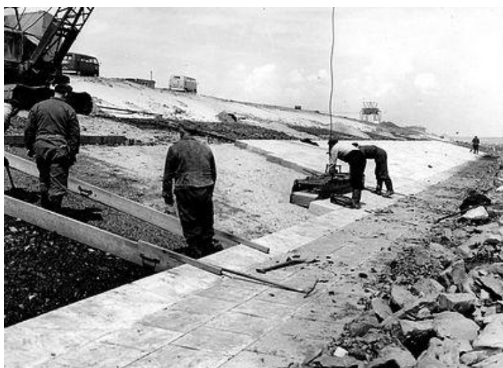
Εικόνα 82. Σφράγισμα με τσιμεντένια στοιχεία.
