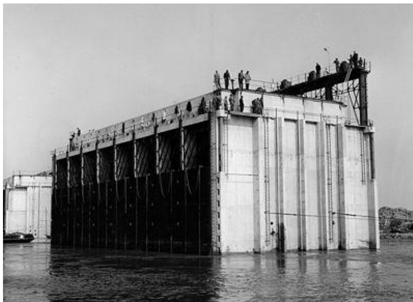
Εικόνα 72. Μεταφορά τσιμεντένιων μπλοκ.
