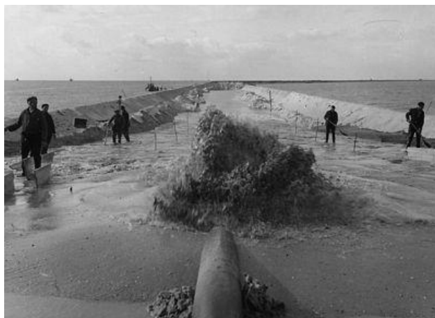
Εικόνα 33. Τοποθέτηση άμμου.
