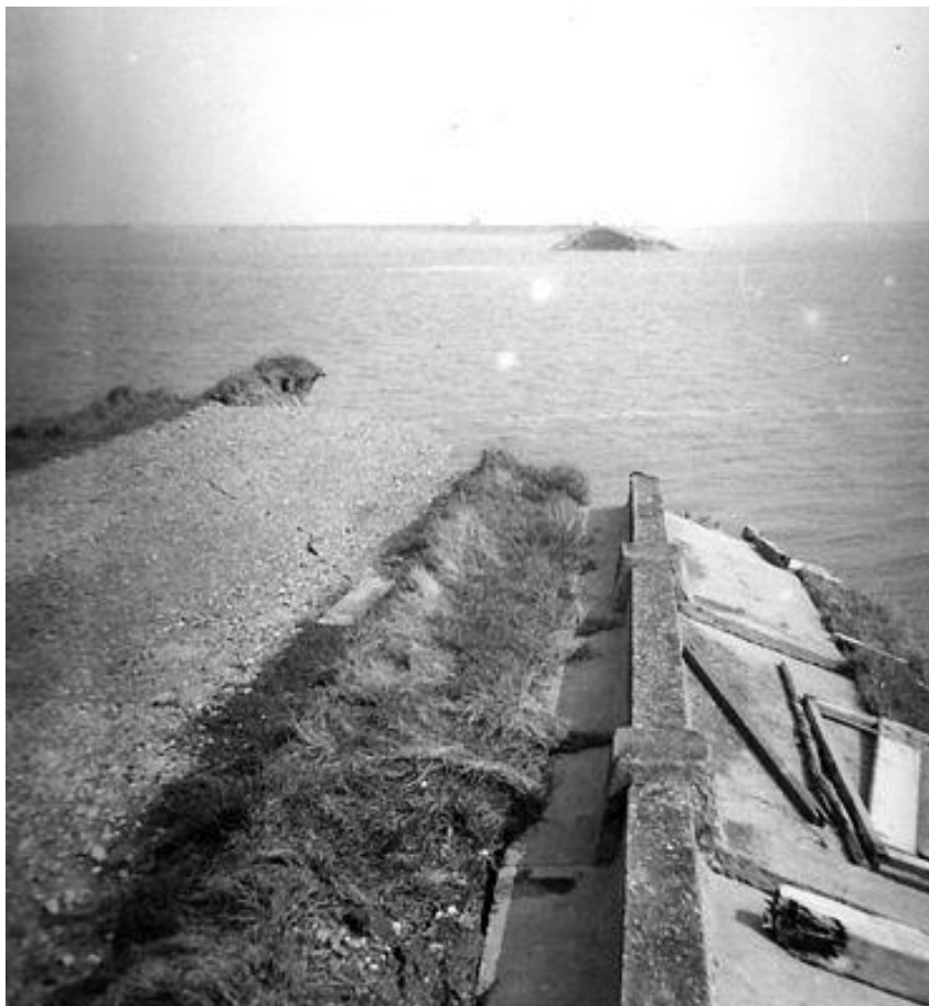
Εικόνα 39. Καταστροφή αναχώματος στην περιοχή Schelphoek.
