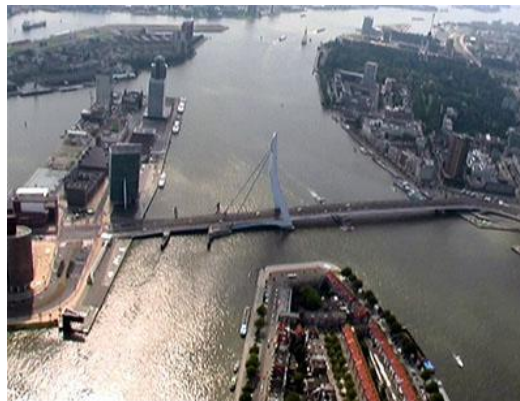
Εικόνα 136. Γέφυρα στο λιμάνι του Ρότερνταμ στη Νέα Πλωτή Οδό.
