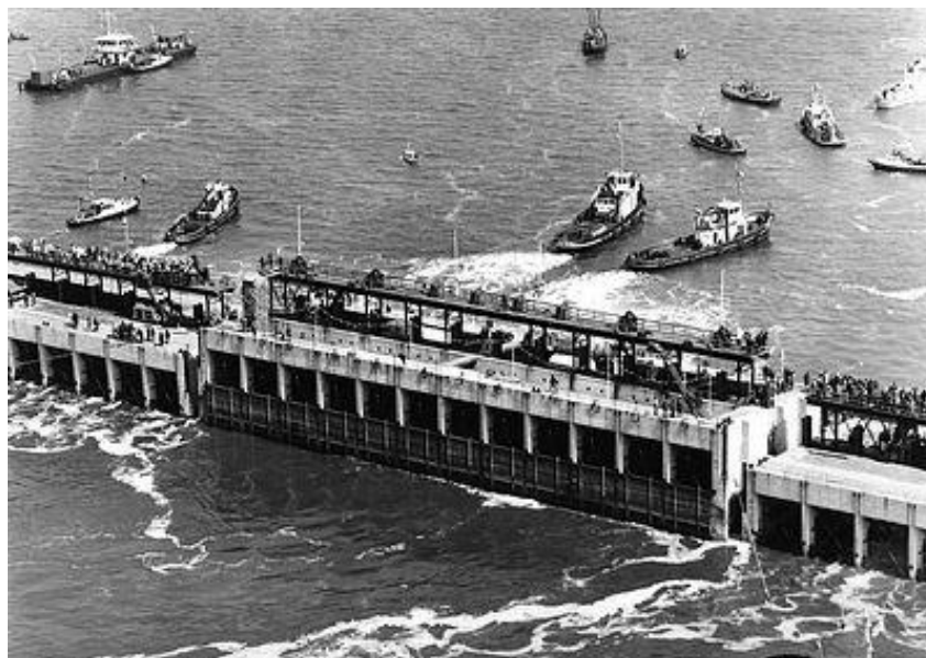
Εικόνα 109. Τοποθέτηση τσιμεντένιου στοιχείου.
