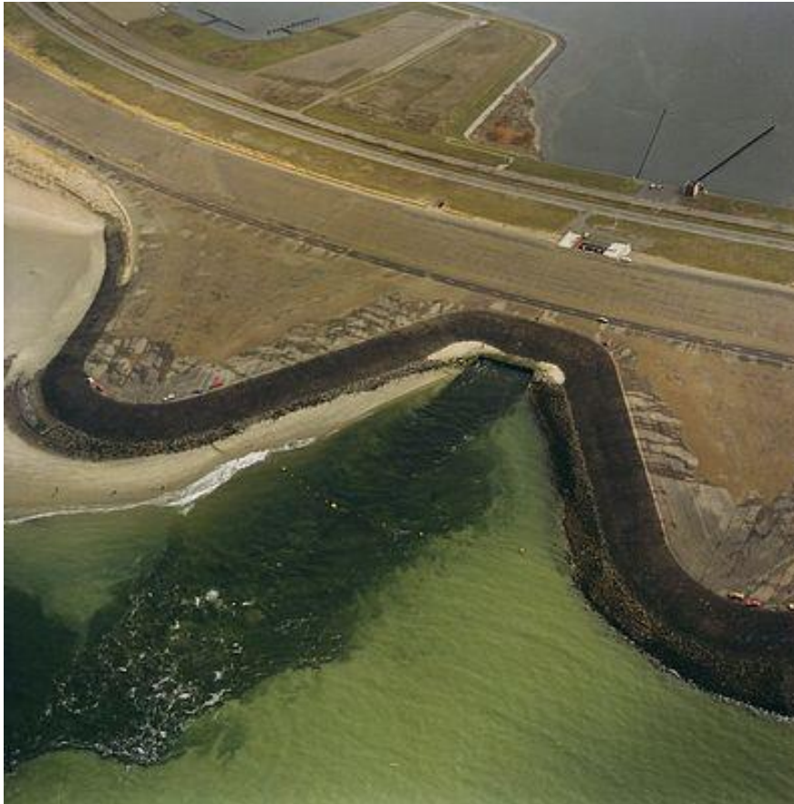
Εικόνα 112. Θυρόφραγμα στο φράγμα Brouwers.
