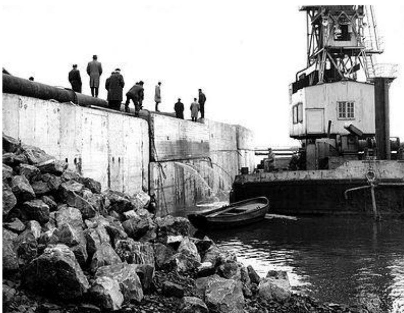
Εικόνα 83. Πλήρωση κενών με άμμο.
