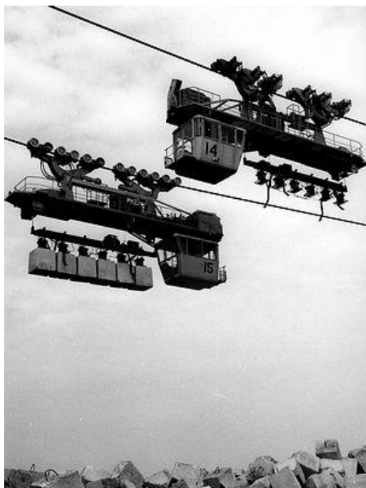
Εικόνα 104. Μεταφορά τσιμεντένιων μπλοκ.
