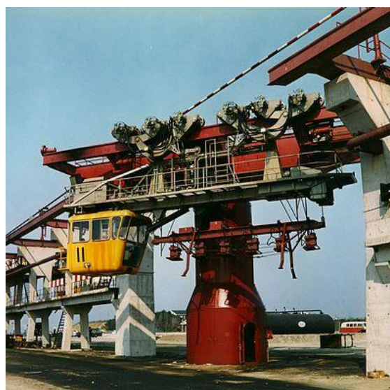
Εικόνα 106. Σύστημα μεταφοράς τσιμεντένιων μπλοκ.
