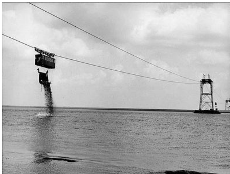
Εικόνα 84. Απόρριψη πετρών στη θάλασσα.
