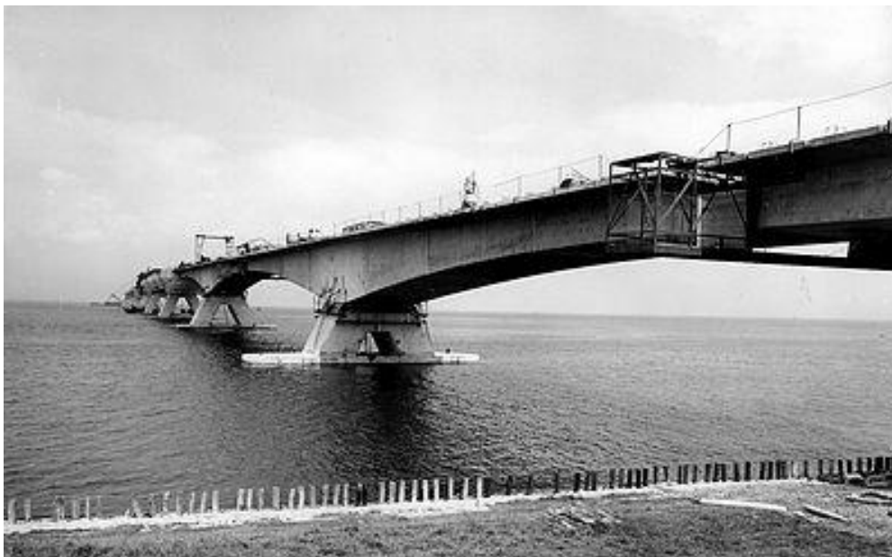
Εικόνα 153. Κατασκευή της γέφυρας Zeeland.
