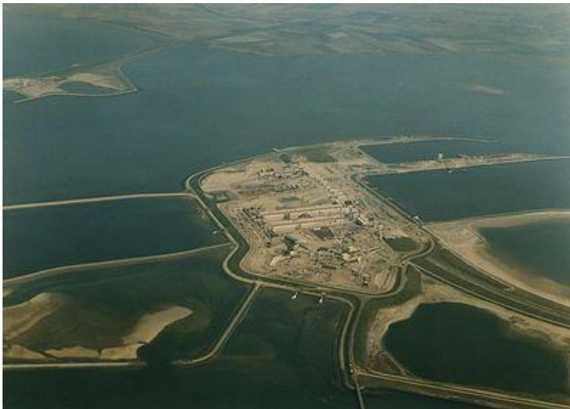
Εικόνα 148. Τεχνητό νησί εργασιών κατασκευής φράγματος.
