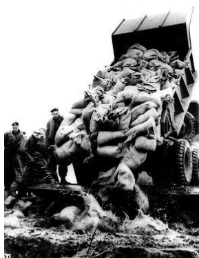
Εικόνα 49. Προστασία με τοποθέτηση αμμόσακων.
