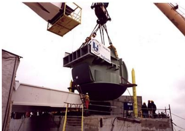
Εικόνα 137. Αρθρωτοί μηχανισμοί θυρών.
