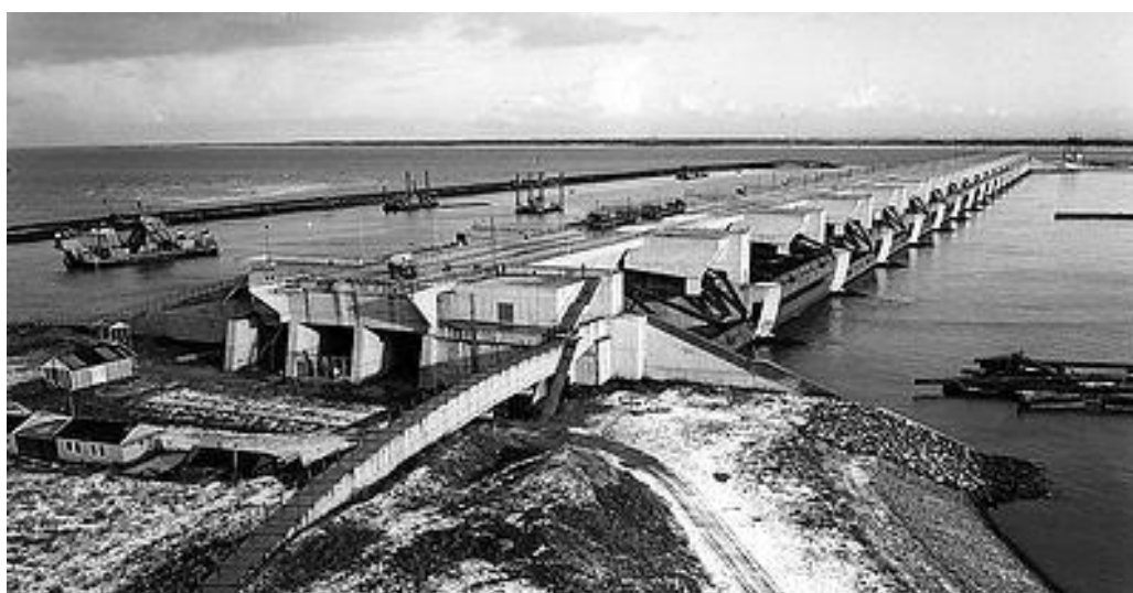
Εικόνα 100. Χώρος εκσκαφών του φράγματος μετά την απομάκρυνση του βοηθητικού αναχώματος.
