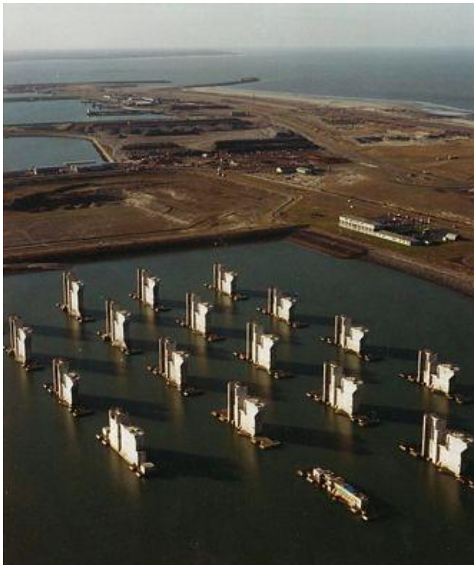
Εικόνα 121. Τοποθέτηση προβλητών.
