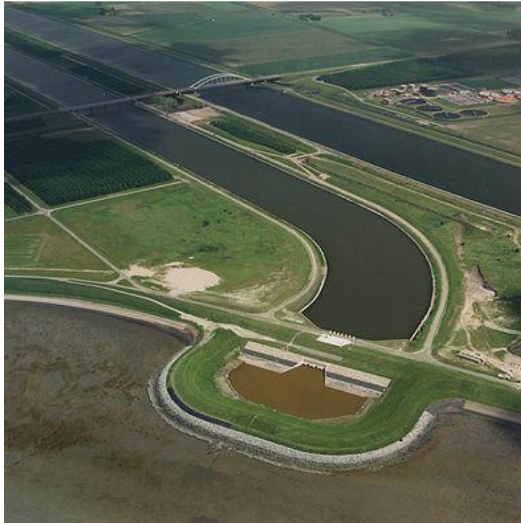
Εικόνα 151. Κανάλι και θυρόφραγμα στην περιοχή Bath.
