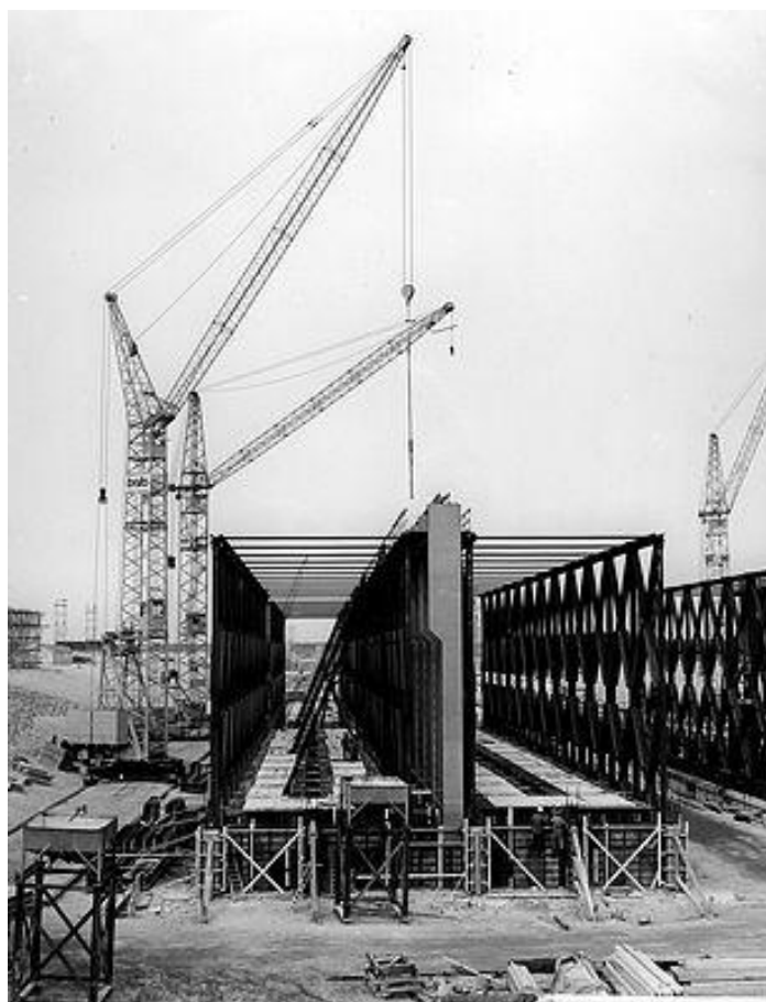
Εικόνα 107. Κατασκευή τσιμεντένιων μπλοκ.
