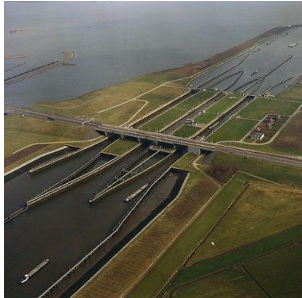
Εικόνα 91. Τα θυροφράγματα στο φράγμα Volkerak.
