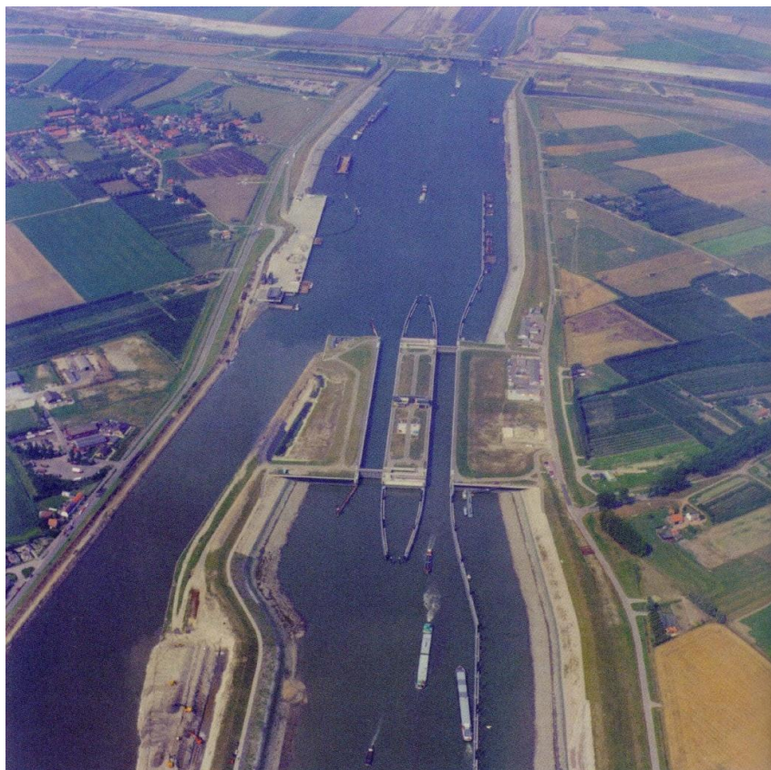
Εικόνα 150. Το κανάλι αποστράγγισης στην περιοχή Bath.
