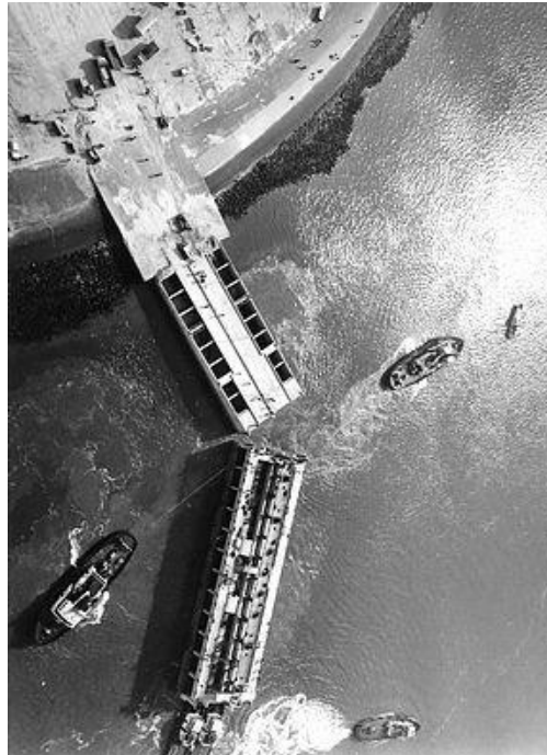
Εικόνα 108. Μετακίνηση τσιμεντένιου στοιχείου.
