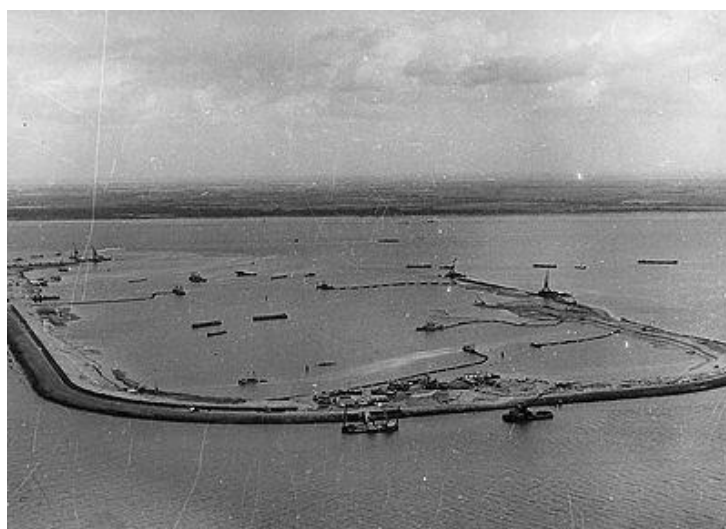
Εικόνα 98. Χώρος εκσκαφών του φράγματος με το βοηθητικό ανάχωμα.
