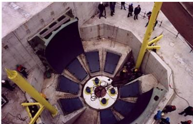
Εικόνα 138. Θεμελίωση αρθρωτών μηχανισμών θυρών.
