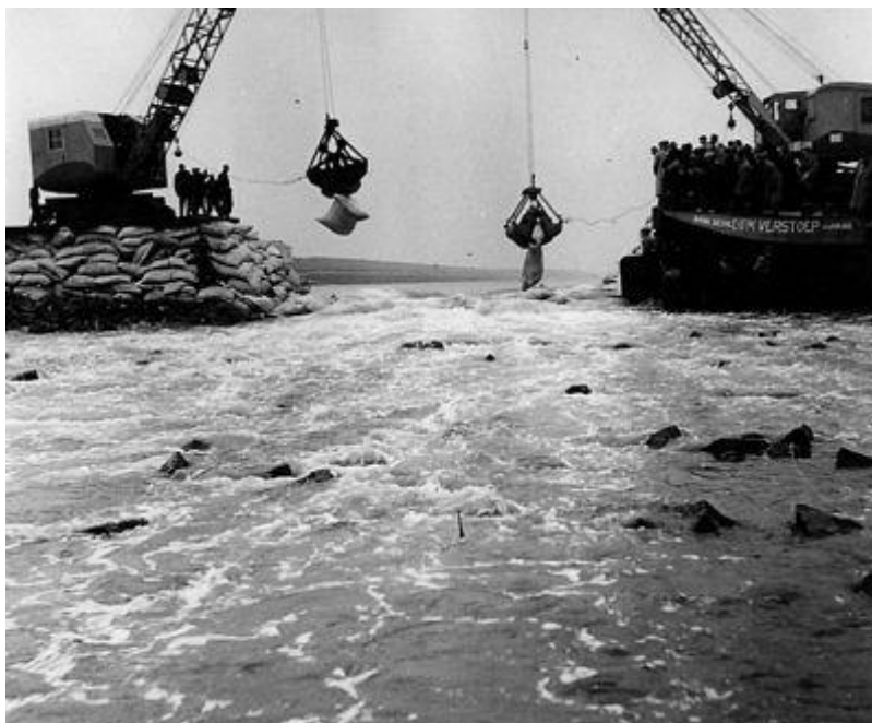
Εικόνα 45. Φράξιμο με αμμόσακους.
