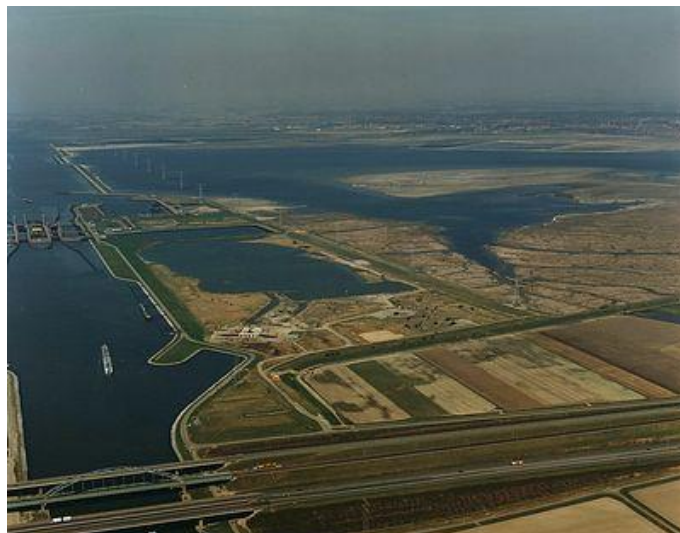
Εικόνα 142. Τα θυροφράγματα Kreekrak.
