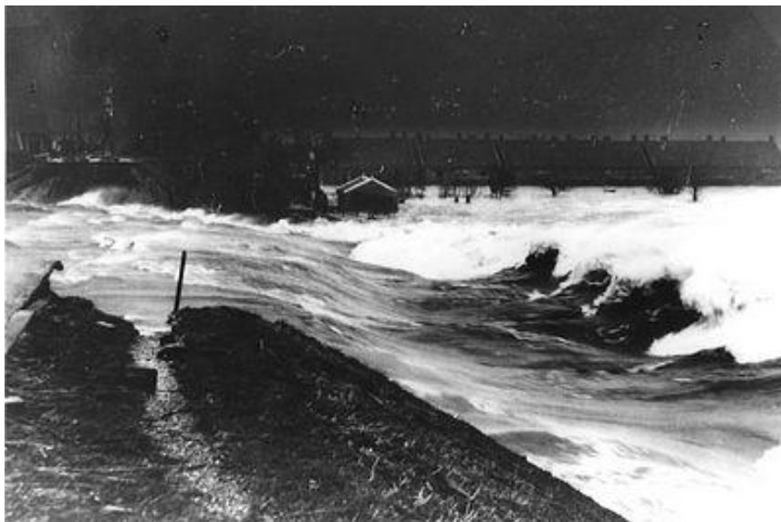
Εικόνα 40. Εισροή θάλασσας σε ανάχωμα.
