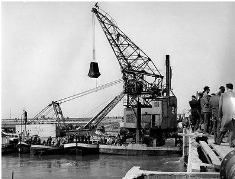
Εικόνα 67. Κατασκευή τσιμεντένιων μπλοκ.
