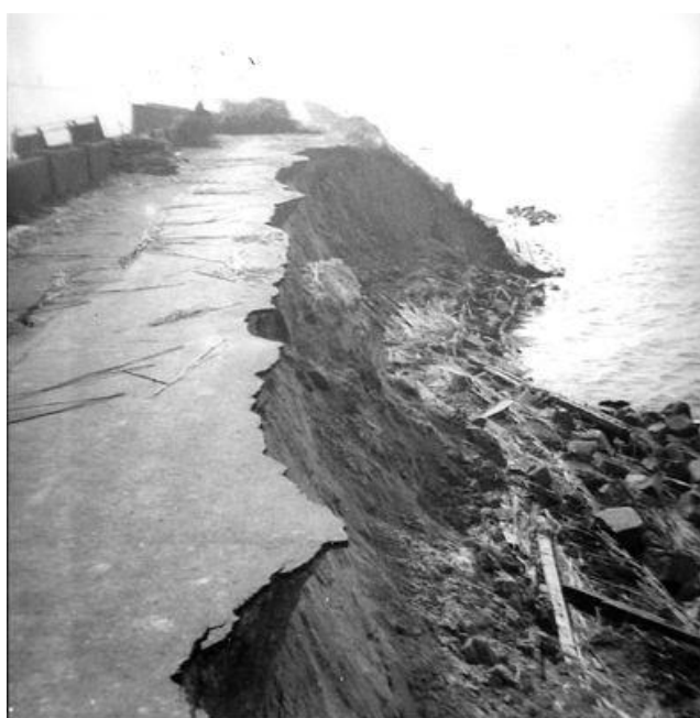
Εικόνα 38. Υποσκαφή αναχώματος.
