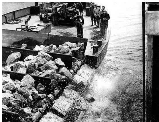
Εικόνα 92. Απόρριψη ογκόλιθων.
