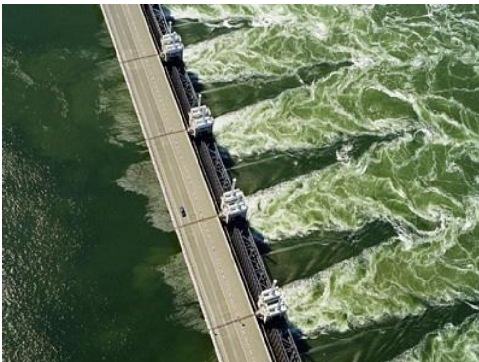
Εικόνα 114. Εκροή νερού στο φράγμα Oosterschelde.
