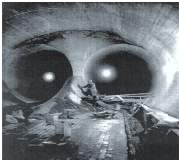
Εικόνα 3.3. Κατασκευή δίδυμου αποχετευτικού αγωγού το 1939 στην Αθήνα (πηγή: ΕΥΔΑΠ)
