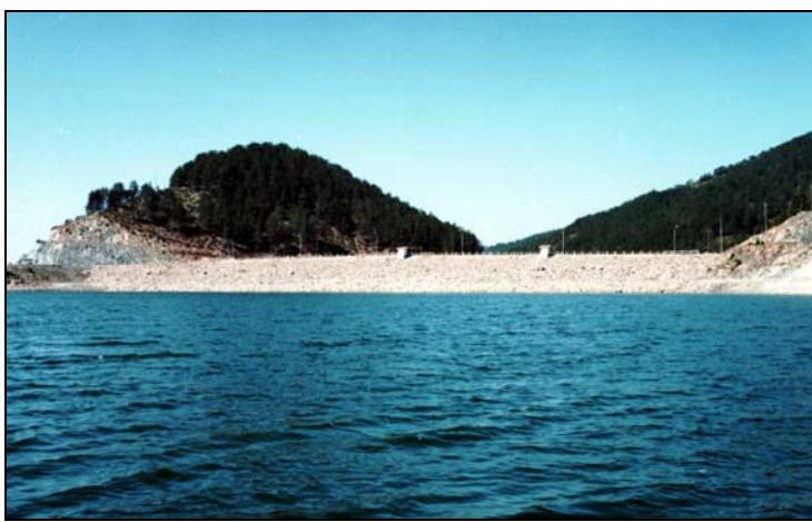
Εικόνα 2: Το κύριο φράγμα του ΥΣ όπως φαίνεται μέσα από τη λίμνη (Πηγή: Δ/ση ΥΗΣ Πηγών Αώου)
