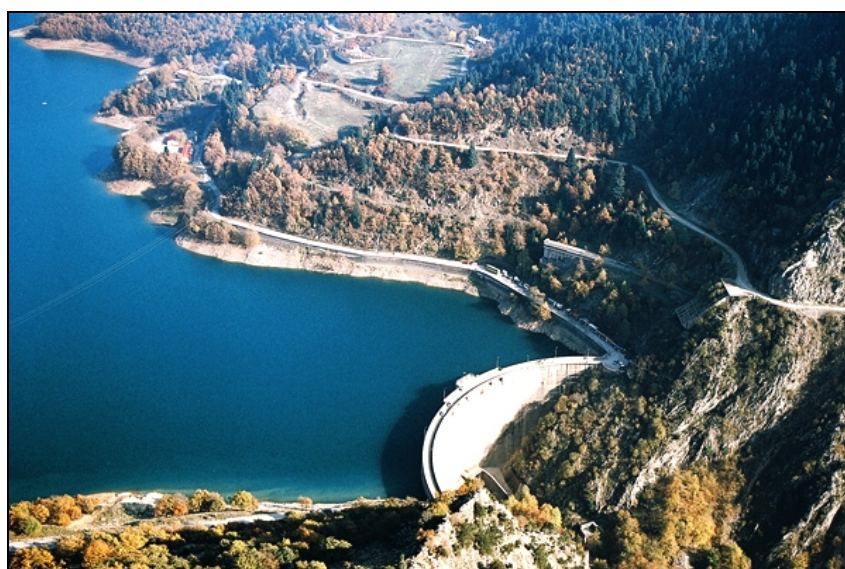
Εικόνα 31: Το τοξωτό φράγμα της λίμνης Πλαστήρα
