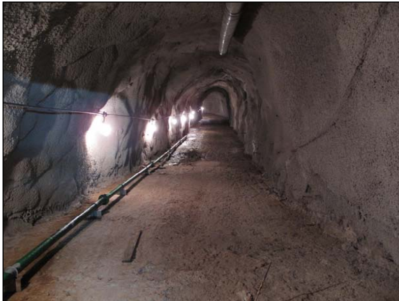
Εικόνα 18: Το εσωτερικό της σήραγγας φυγής
