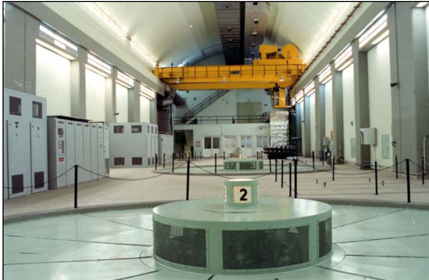
Εικόνα 15: Άποψη του επάνω επιπέδου
