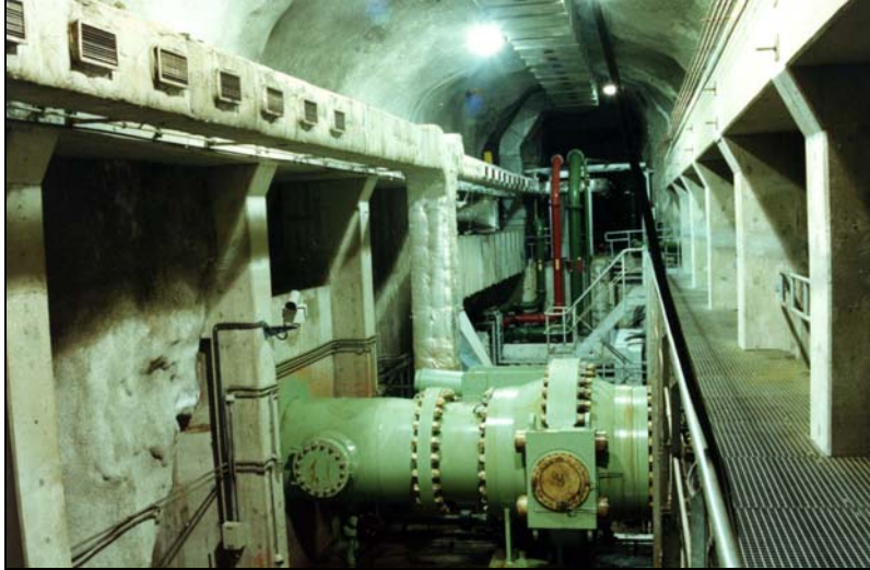
Εικόνα 19: Ο θάλαμος των κατάντη σφαιρικών βαλβίδων
