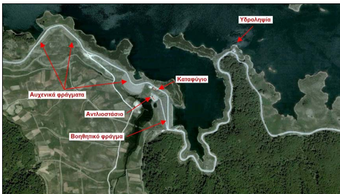
Εικόνα 4: Η περιοχή εγκαταστάσεων 1 με τα τρία αυχενικά φράγματα, το βοηθητικό φράγμα, την υδροληψία και το αντλιοστάσιο Πολιτσών
