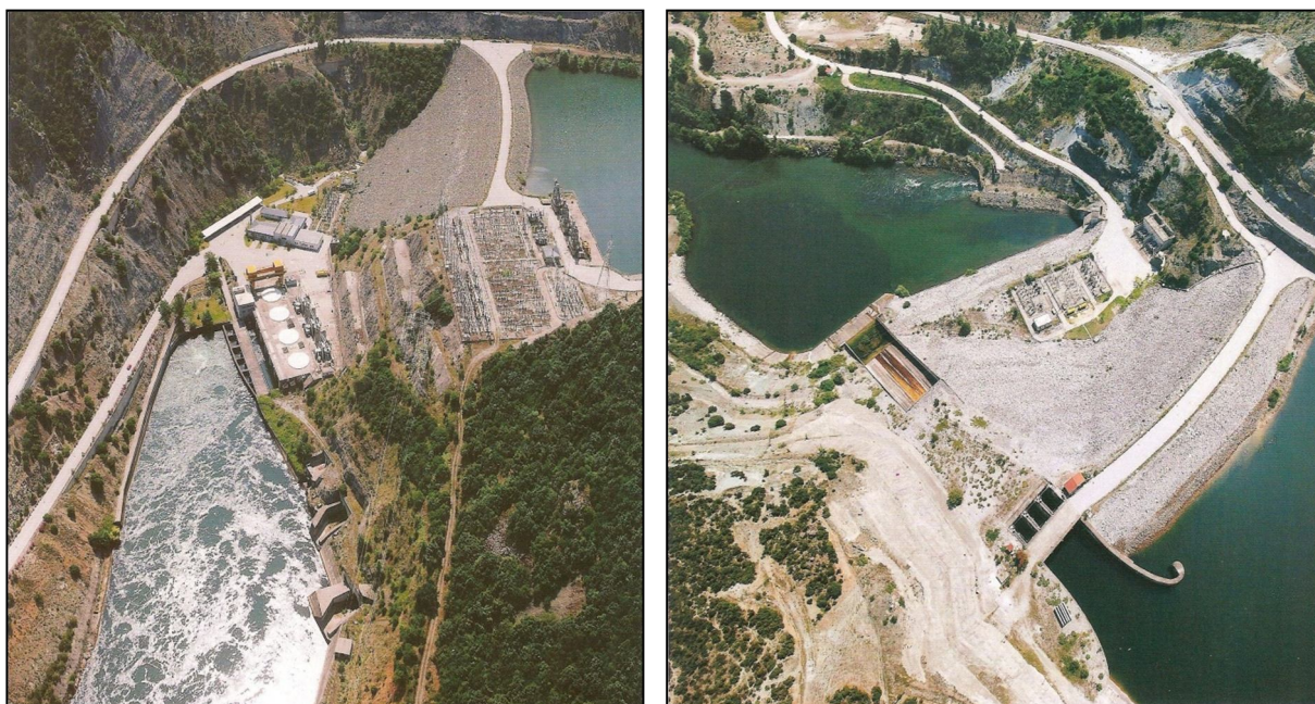
Εικόνα 2.7 Αριστερά το υδροηλεκτρικό στη Σφηκιά και δεξιά στα Ανώματα (πηγή: ΔΑΥΕ-ΔΕΗ ΑΕ.)
