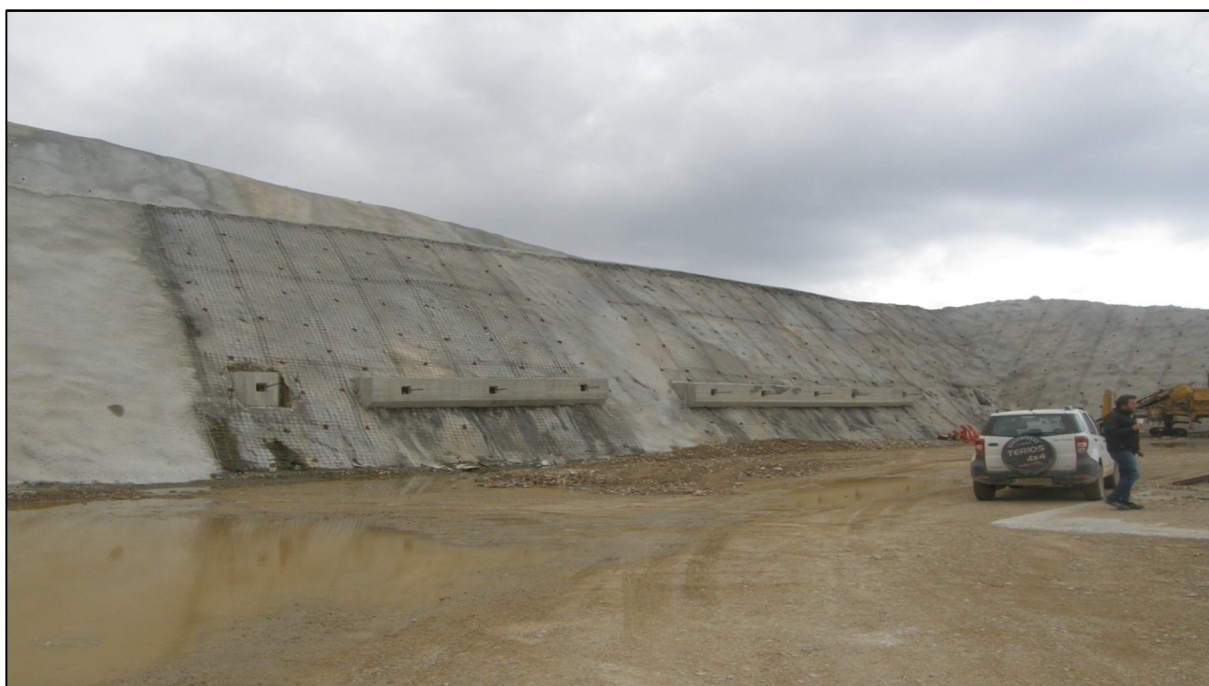
Εικόνα 4.4 Περιοχή κατασκευής του ΥΗΣ Προεσπέρας
