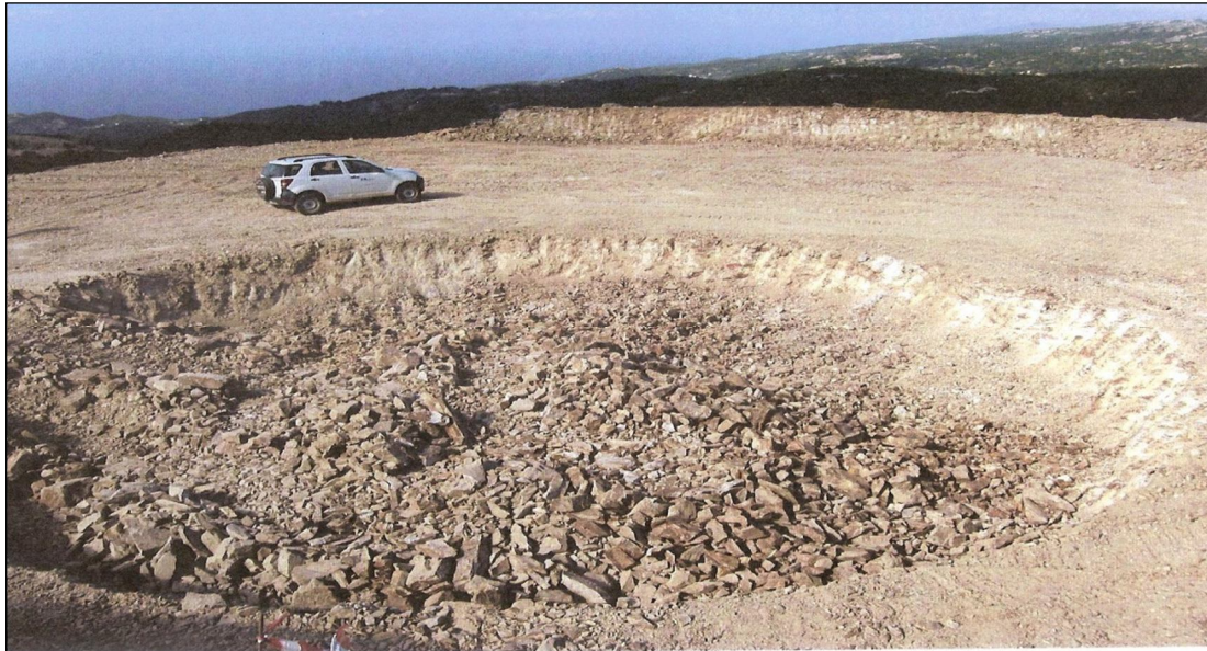
Εικόνα 4.7 Εκσκαφή θεμελίου ανεμογεννήτριας (πηγή: ΔΕΗ ΑΝΑΝΕΩΣΙΜΕΣ ΑΕ, 2011)
