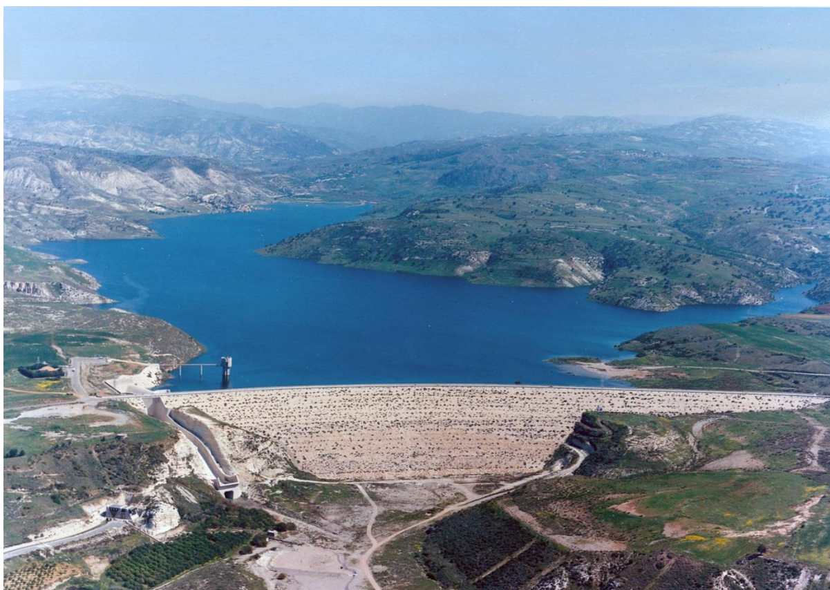
Εικόνα 4.9 Το φράγμα Ασπρόκρεμμου με τον ανάντη ταμιευτήρα, ο οποίος με χωρητικότητα 52 \cdot 10^6 κατέχει τη δεύτερη θέση μεταξύ των ταμιευτήρων σε ολόκληρη την Κύπρο (Τμήμα Ανάπτυξης Υδάτων Κύπρου) (Πηγή: http://www.jandpcy.com/el/Asprokremmos-Dam-gr ).
