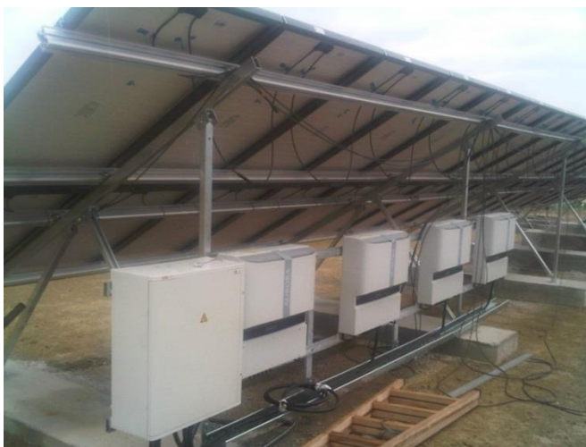
Σύνδεση ηλεκτρολογικού εξοπλισμού
