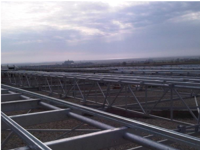
Συναρμολόγηση μεταλλικού σκελετού βάσεων
