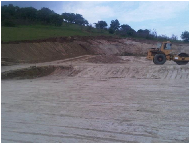
Καθαρισμός & διαμόρφωση περιβάλλοντος χώρου
